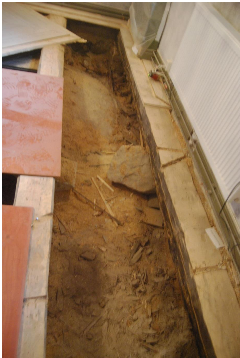
Figur 3. Östra delen av sakristian innan undersökningen. I bakgrunden skymtar källartaket fram. Foto från söder.
