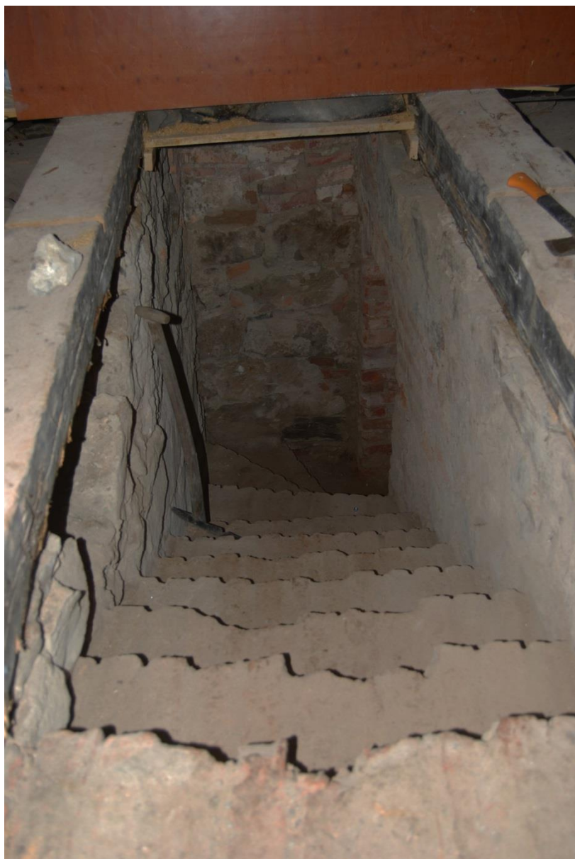
Figur 11. Den murade källartrappen. Foto från söder.
