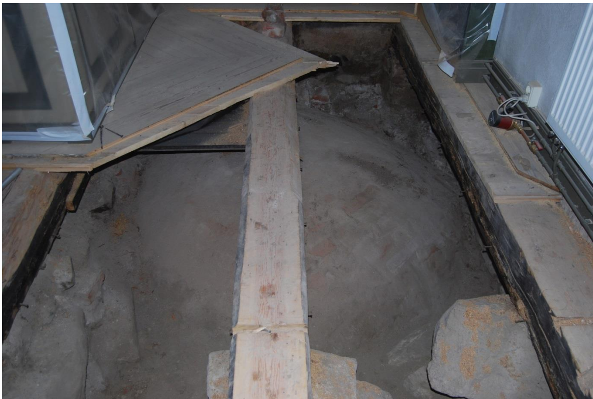
Figur 4. Det välvda taket på källaren efter bortrensning av byggnadsrester. Foto från söder.
