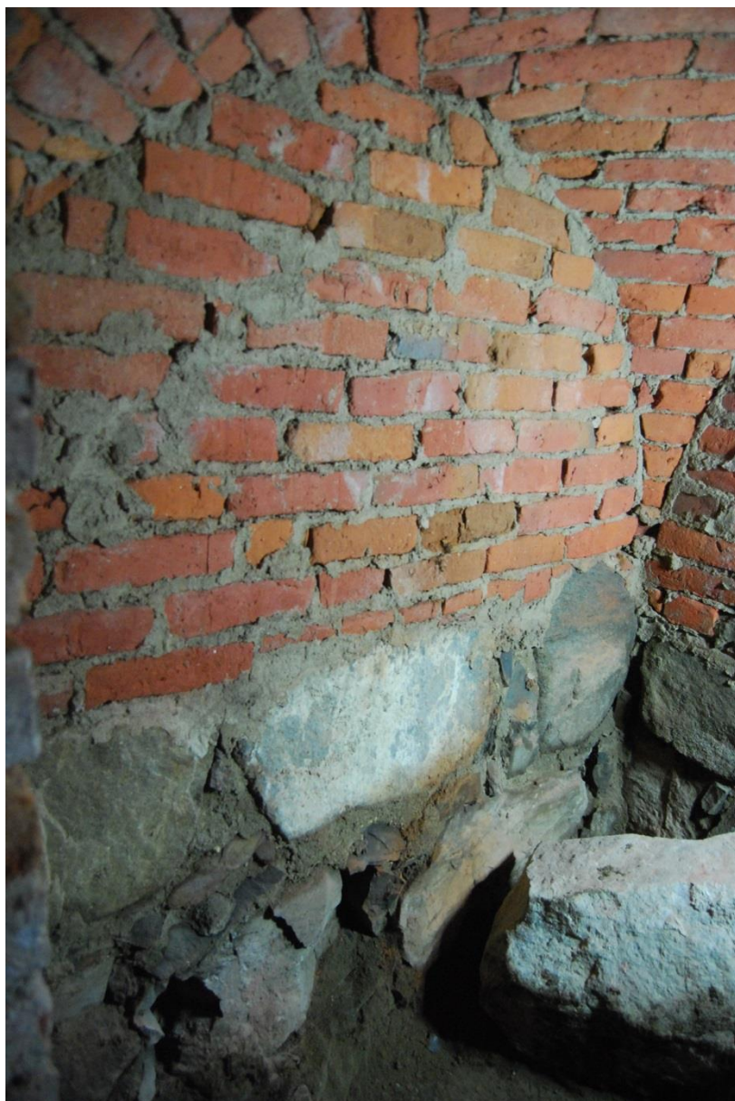
Figur 8. Den norra väggen i källaren. Foto från sydväst inifrån källaren.
