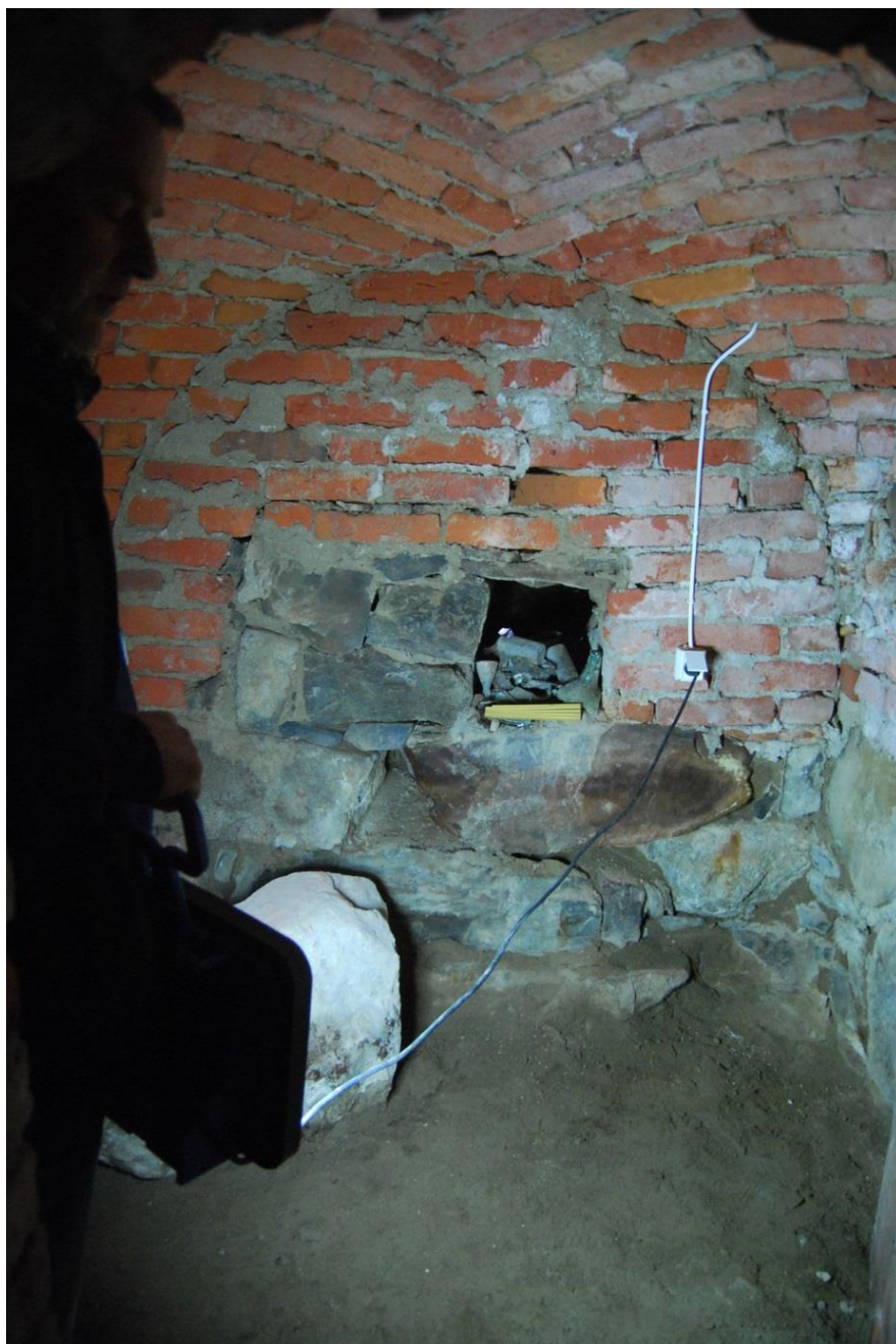
Figur 7. Den östra väggen samt delar av taket i källaren. Eluttaget drogs in i samband med byggarbetena. Foto från väster inifrån källaren.
