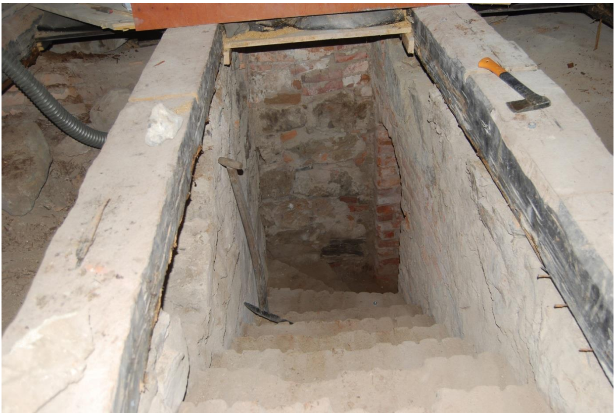
Trappan ner till källaren i sakristian.
