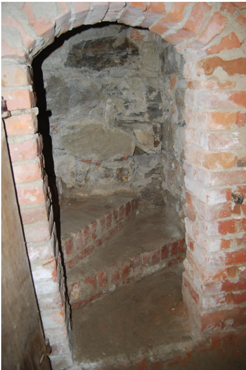
Figur 6. Dörröppningen och delar av trappen. Foto från öster inifrån källaren.
