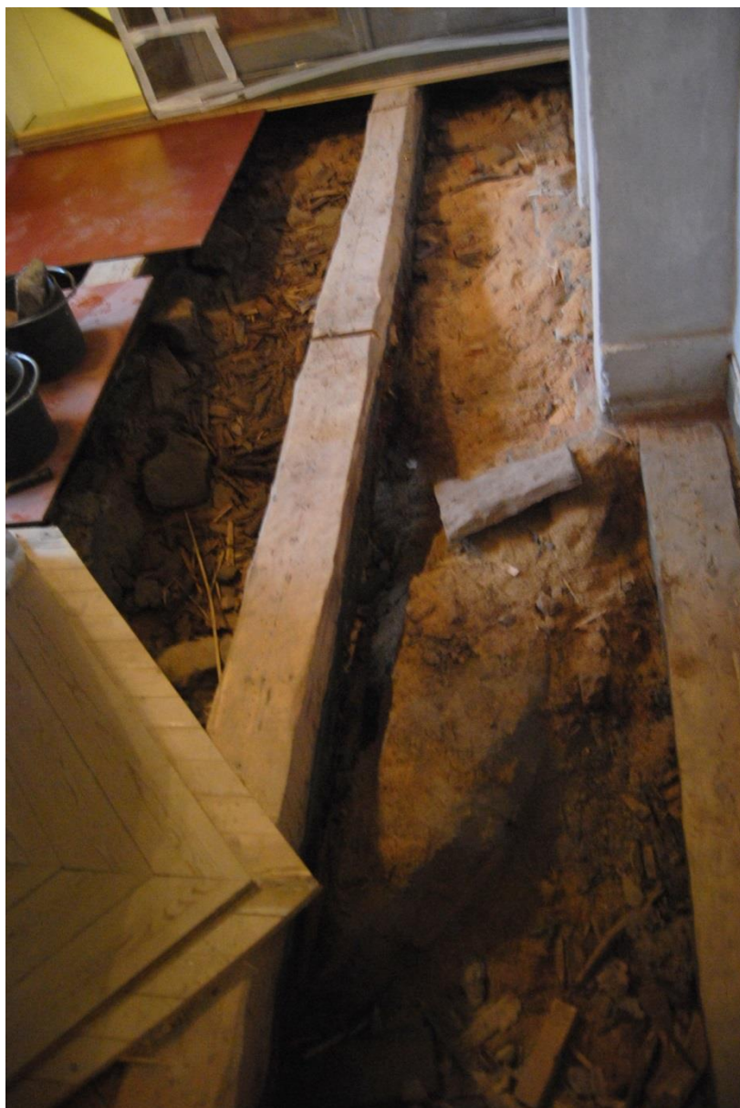
Figur 2. Västra delen av sakristian innan undersökningen med den murade luftkanalen synlig. Foto från norr.
