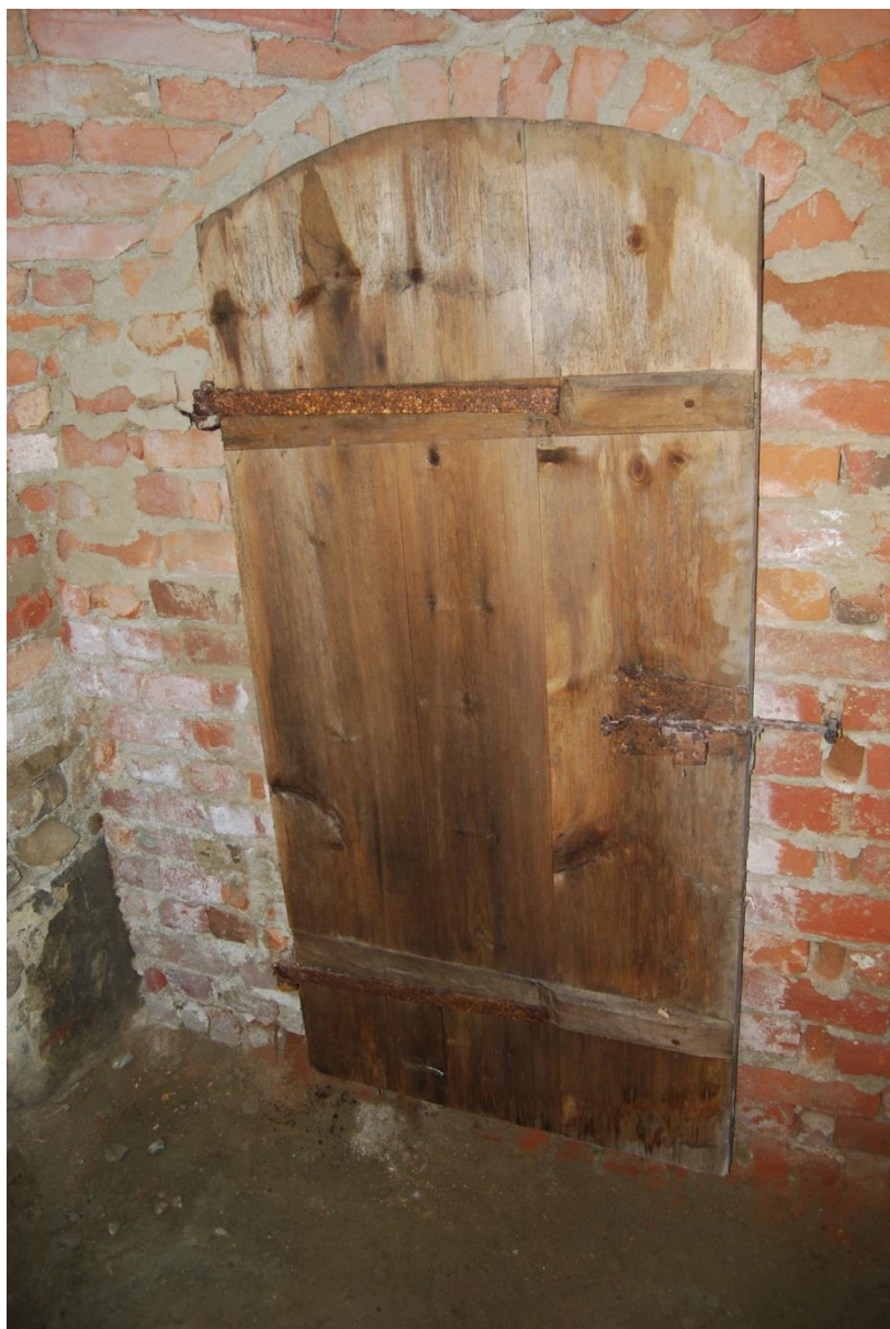
Figur 5. Den västra väggen och dörren i källaren. Foto från öster inifrån källaren.
