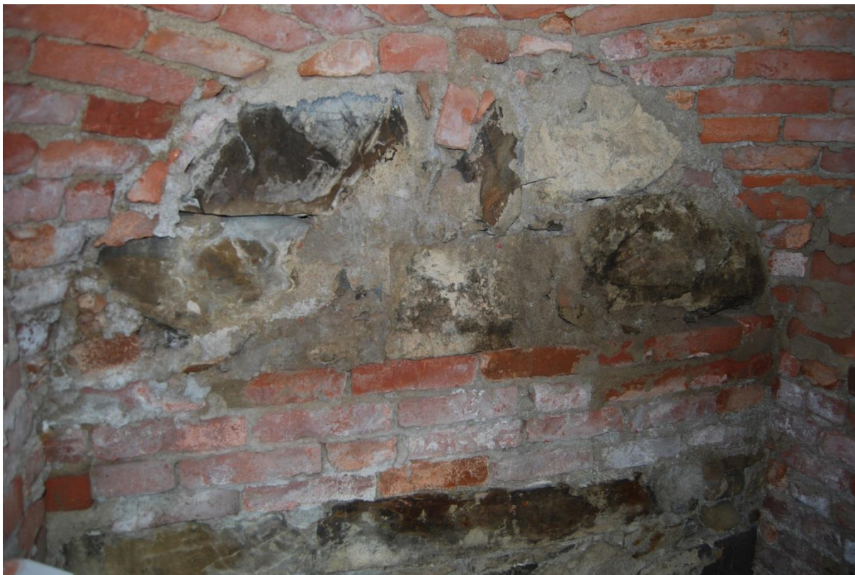
Figur 9. Den södra väggen i källaren. Foto från norr inifrån källaren.
