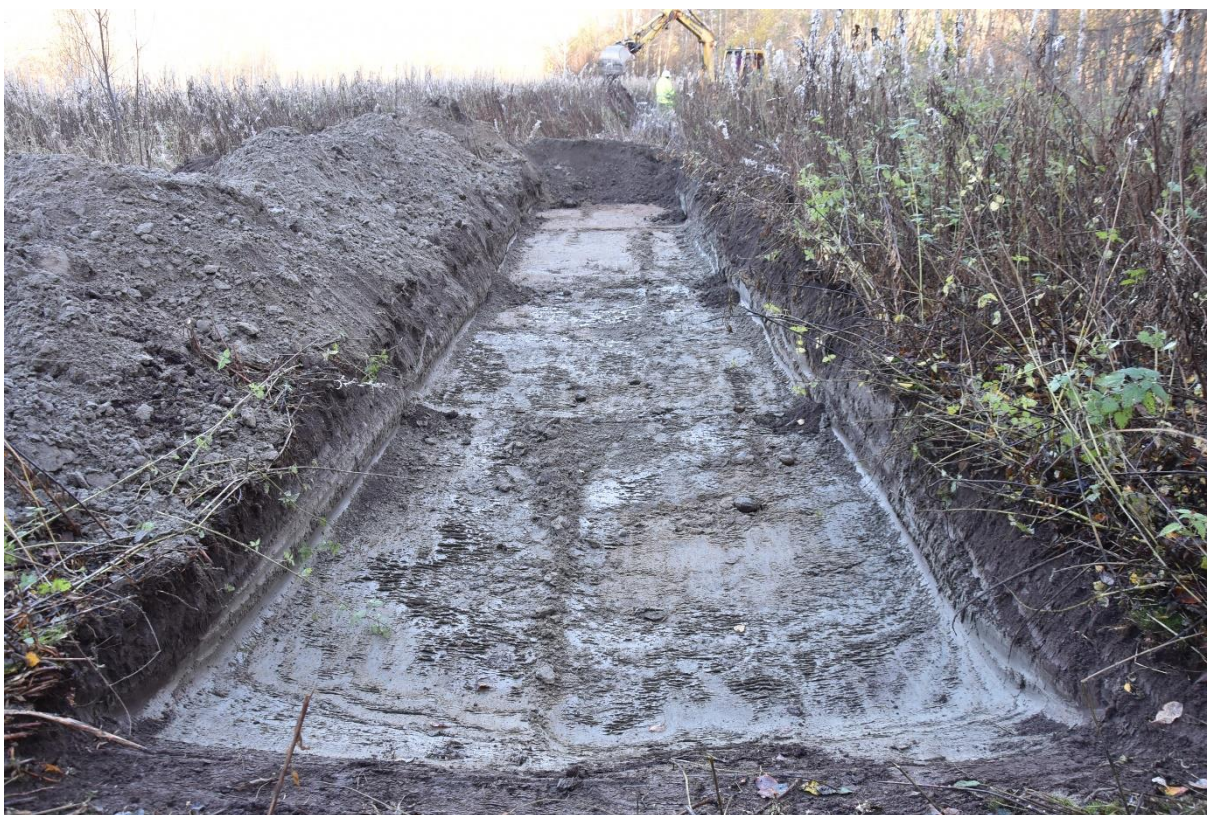
Figur 15. Schakt 23 från väster.
