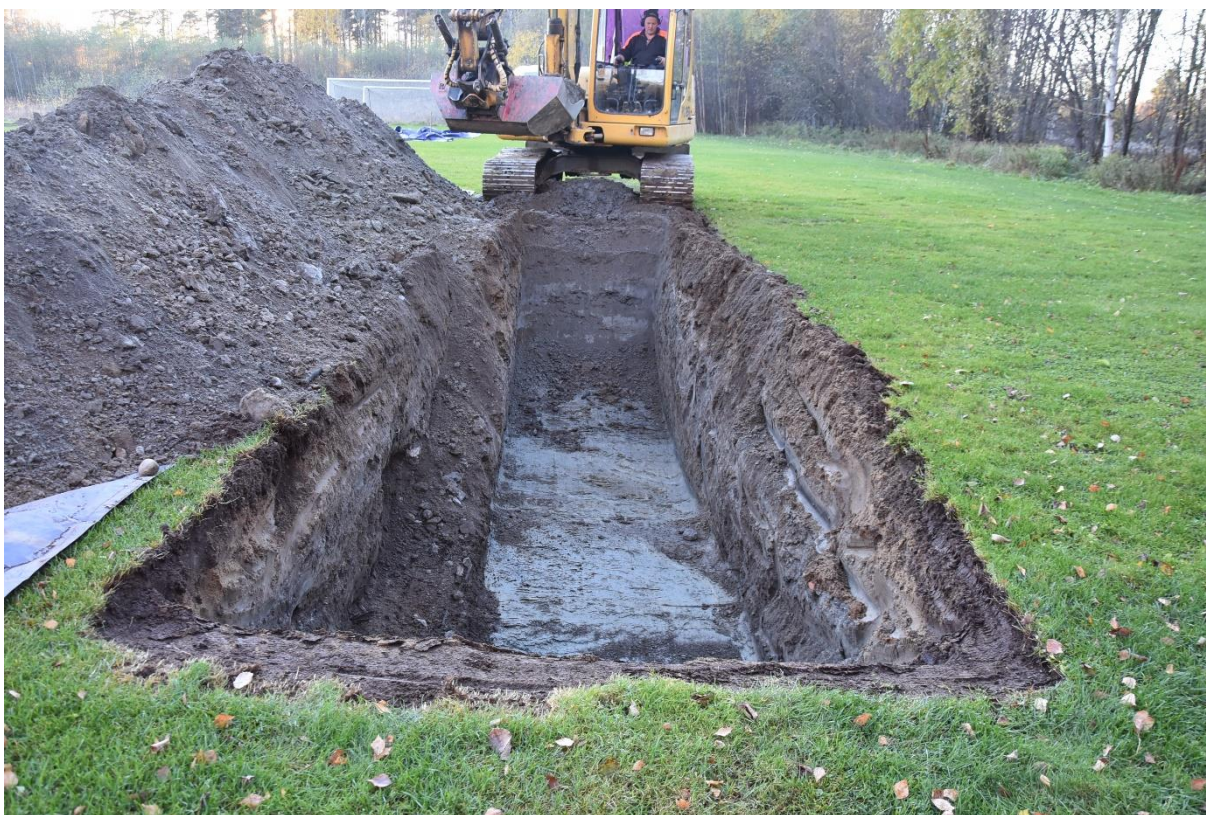
Figur 13. Djupgrävning i schakt 9, från öster.
