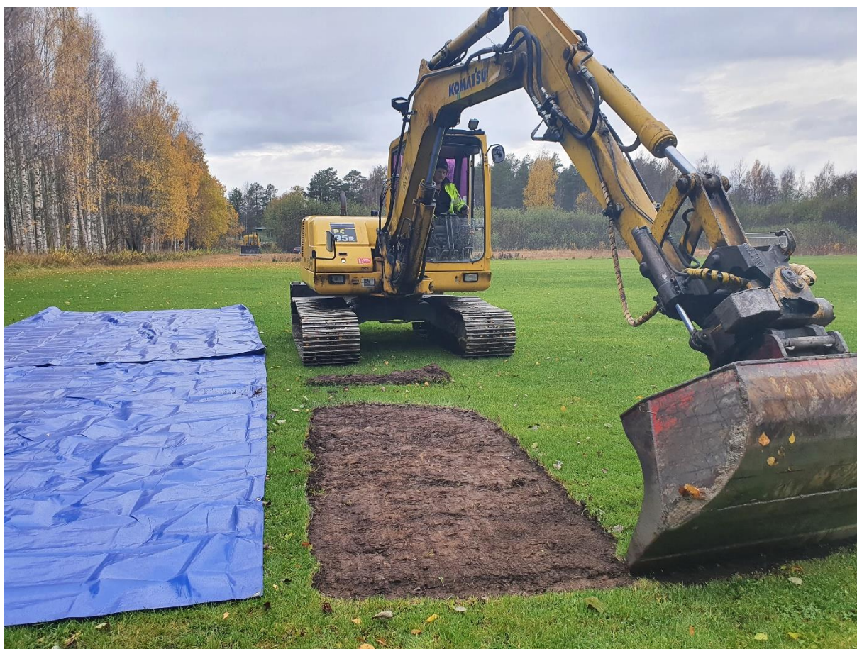
Figur 2. Schaktning på gräsplanen med presenning som underlag. Foto från öster.
