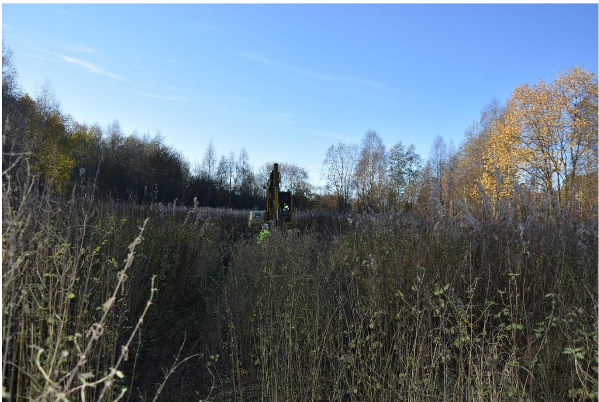
Figur 11. Schaktning på ängen i norra delen av området. Foto från öster.
