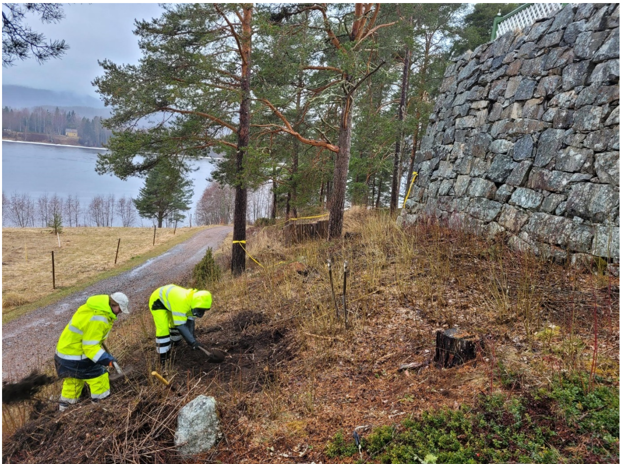
Figur 2. Dåligt väder första dagen när vi grävde schakt 2. Vi begränsade oss till att gräva och sparade på dokumentation till en dag med bättre väder.
