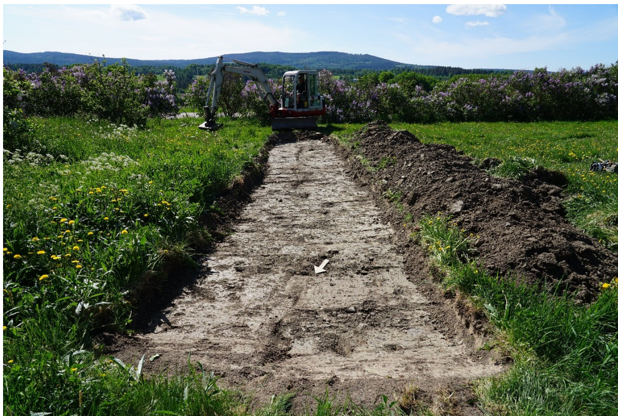
Figur 2. Schakt 1 fotograferat från nordnordväst, med grävmaskin i bakgrunden.
