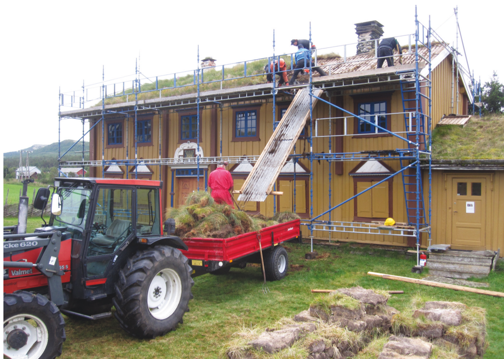
Vedlikeholdsarbeid på tak. Oddentunet, Narjordet. Foto: Nordøsterdalsmuseet.
