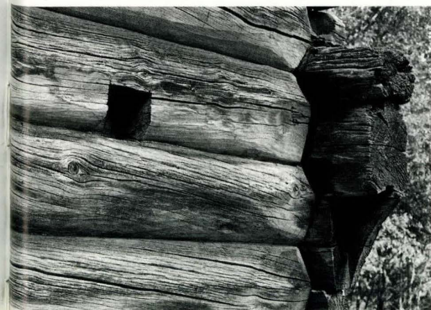
Fig.13. Både de avskårne konsollstokkene for den tidligere svalen og et av bjelkefeste for gulvet i svalgangen sees her tydelig. Foto:GM/Burny Iversen.
