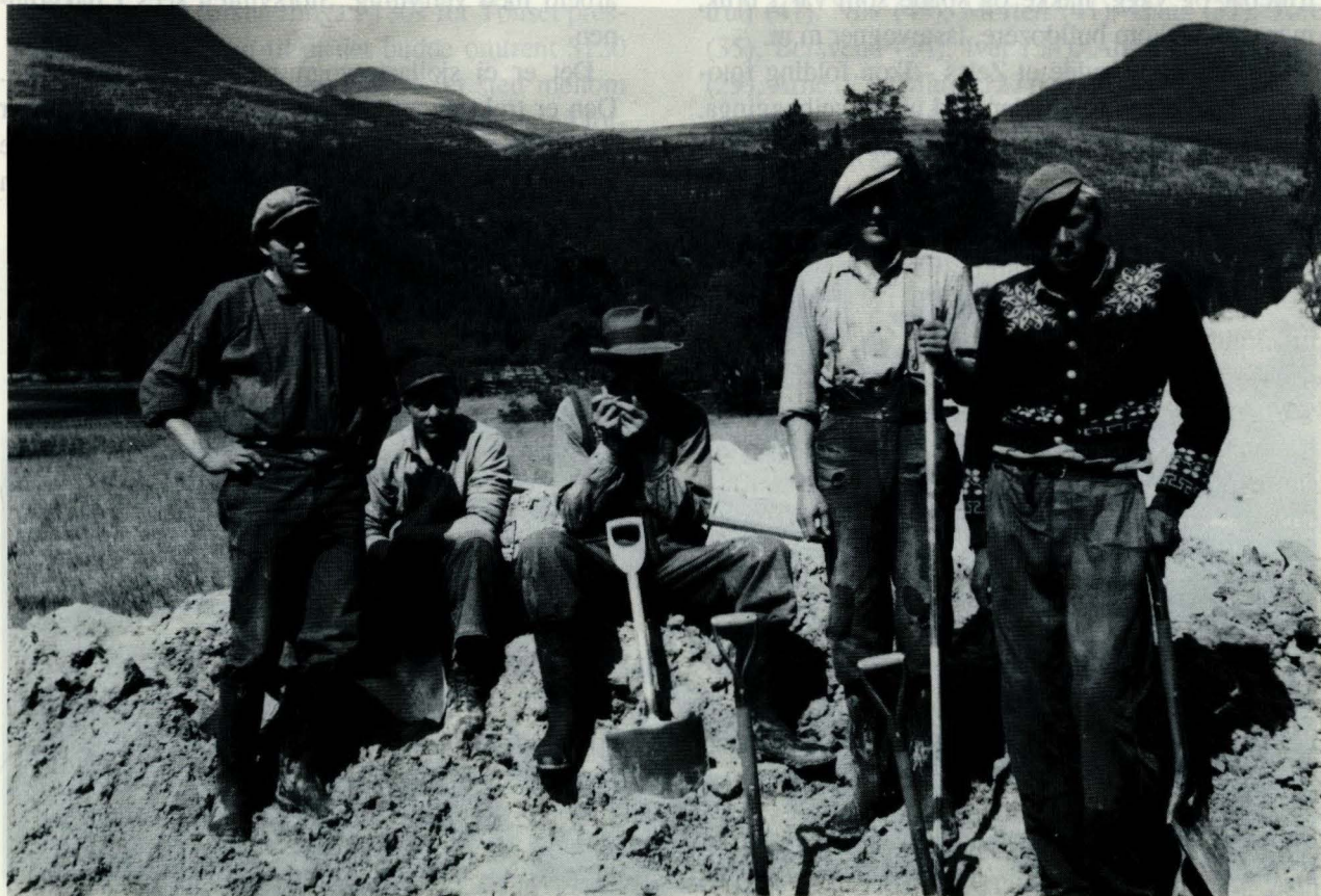
Legging av stikkrenne nord for Nordre Strømbu. (42107)
