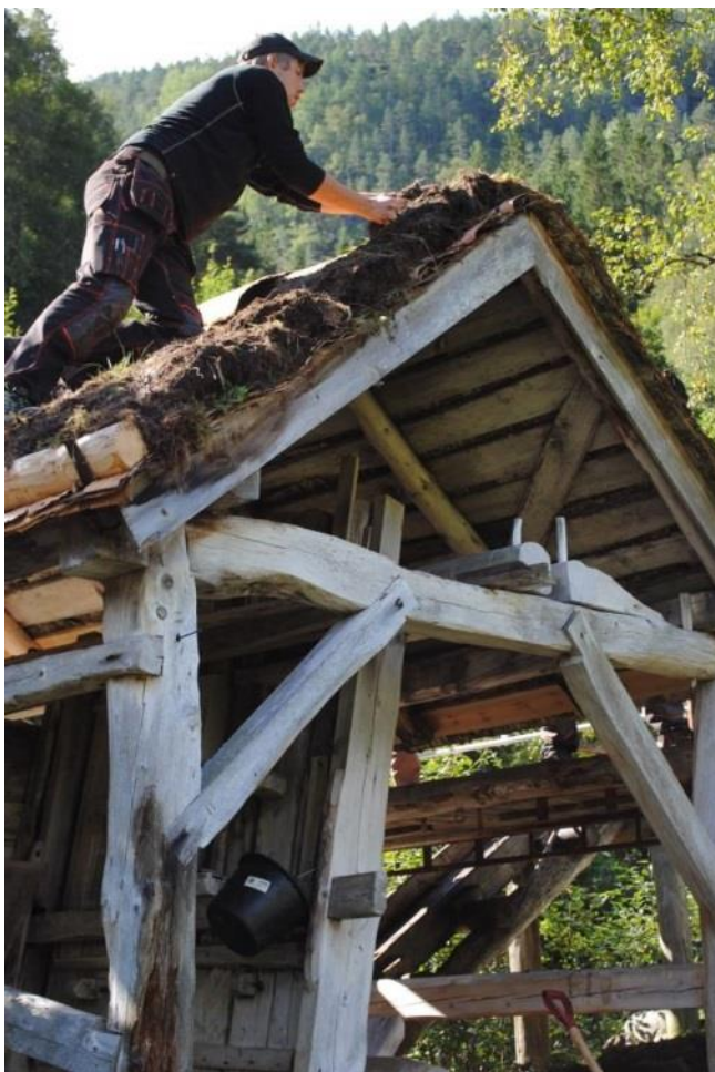
Det blei lagt nytt tak på stampa i 2011. Sven Hoftun på taket.
