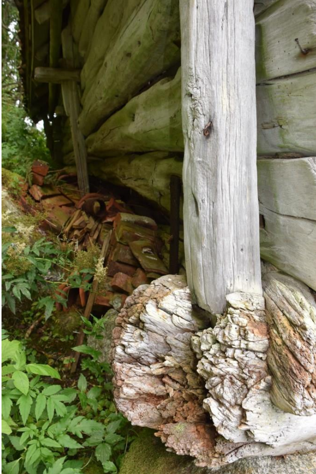
Naustet er i dårleg stand. Det skuldast delvis mye vegetasjon, og at det er stabla panner inntil veggen. Nedste omfaret må truleg skiftast.
