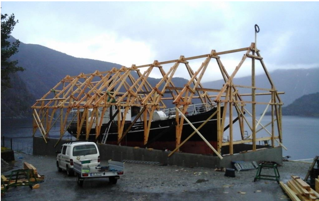
1Båthuset på Strandanes reist i høghustradisjon. Bilde tatt ved kranselag 12. november 2015.
