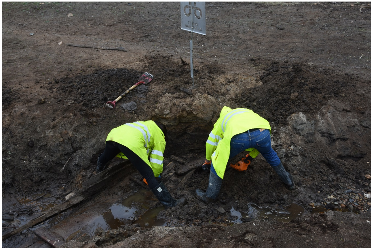
FIGUR 3 UTGRAVNINGEN AV PRAMMEN
