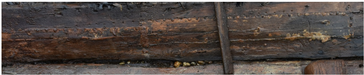
FIG 11 REPARASJONER MED KOBBERSPIKER PÅ STYRBORDSIDEN
