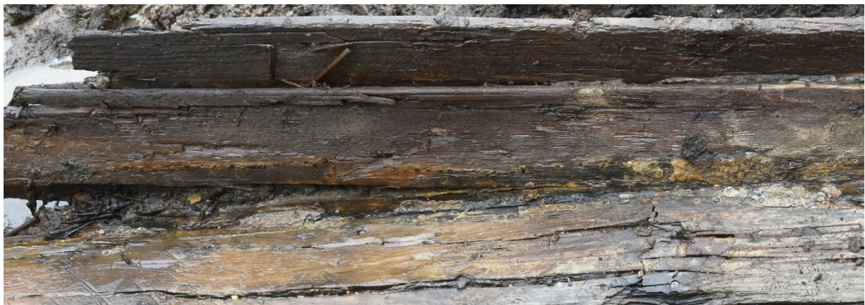
FIG 12 REPARASJONER MED KOBBERSPIKER PÅ BABORDSIDEN
