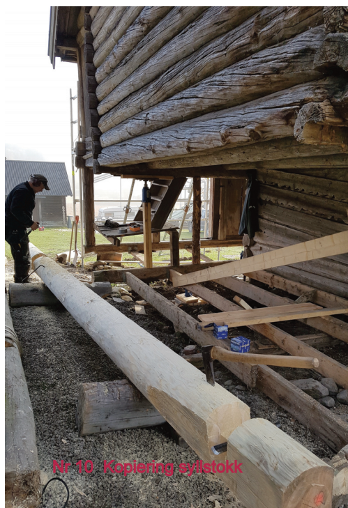
Loftet på Rendalen Bygdetun måtte gjennom en stor restaurering, og her er det håndtverker Jo Aspås som er i aksjon. Foto: Jostein Andersen.
