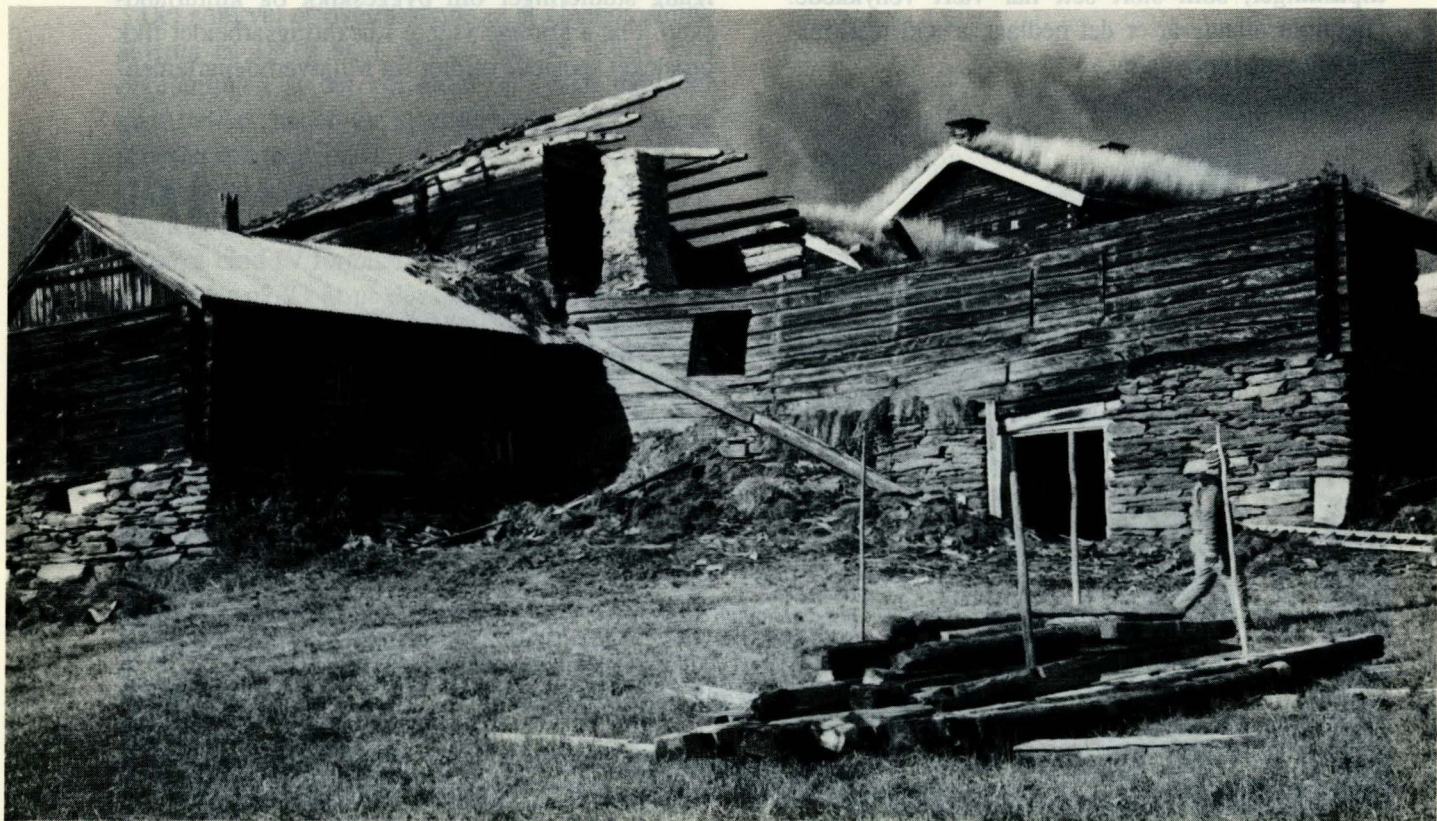
Løa, lemmen, over fjøset er revet, sauffjøs og løe t.v. ble bare jekket opp, trevkløppfoten er murt opp på nytt. Peis og pipe ble ikke rørt. (65893).
