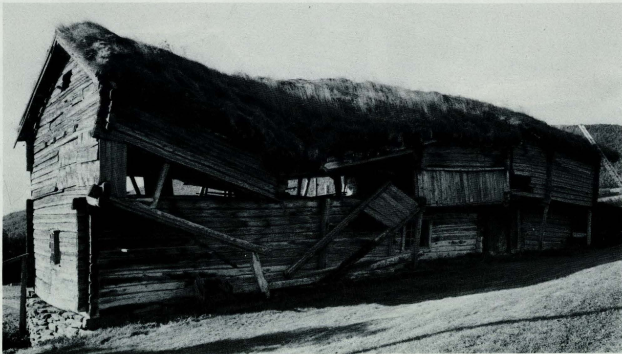
Fjøset i Nyhusa, før arbeidet startet. (65646)
