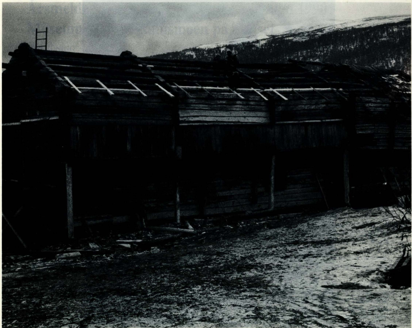
Fjøset har kommet på plass igjen, i botnen måtte det legges inn nytt tømmer, andre steder felt inn, ellers er så mye som mulig av de gamle materialene brukt omatt der de var før. (66406).
