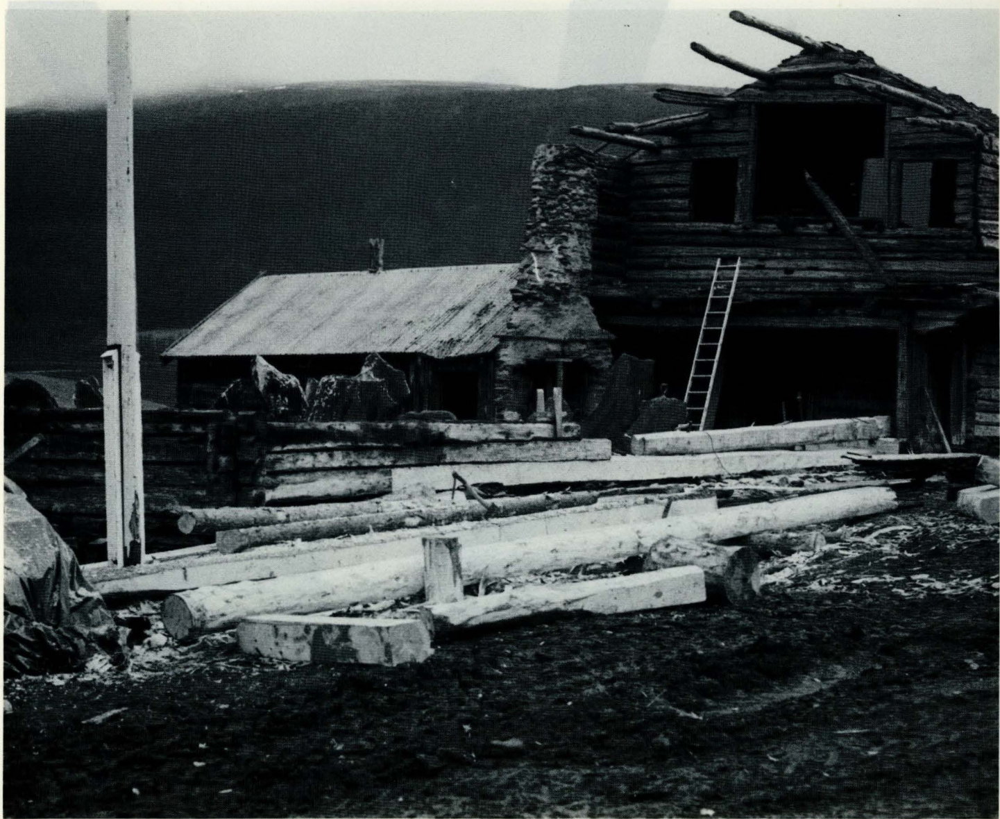
Arbeidet med å legge oppatt fjøset er igang. (66032).
