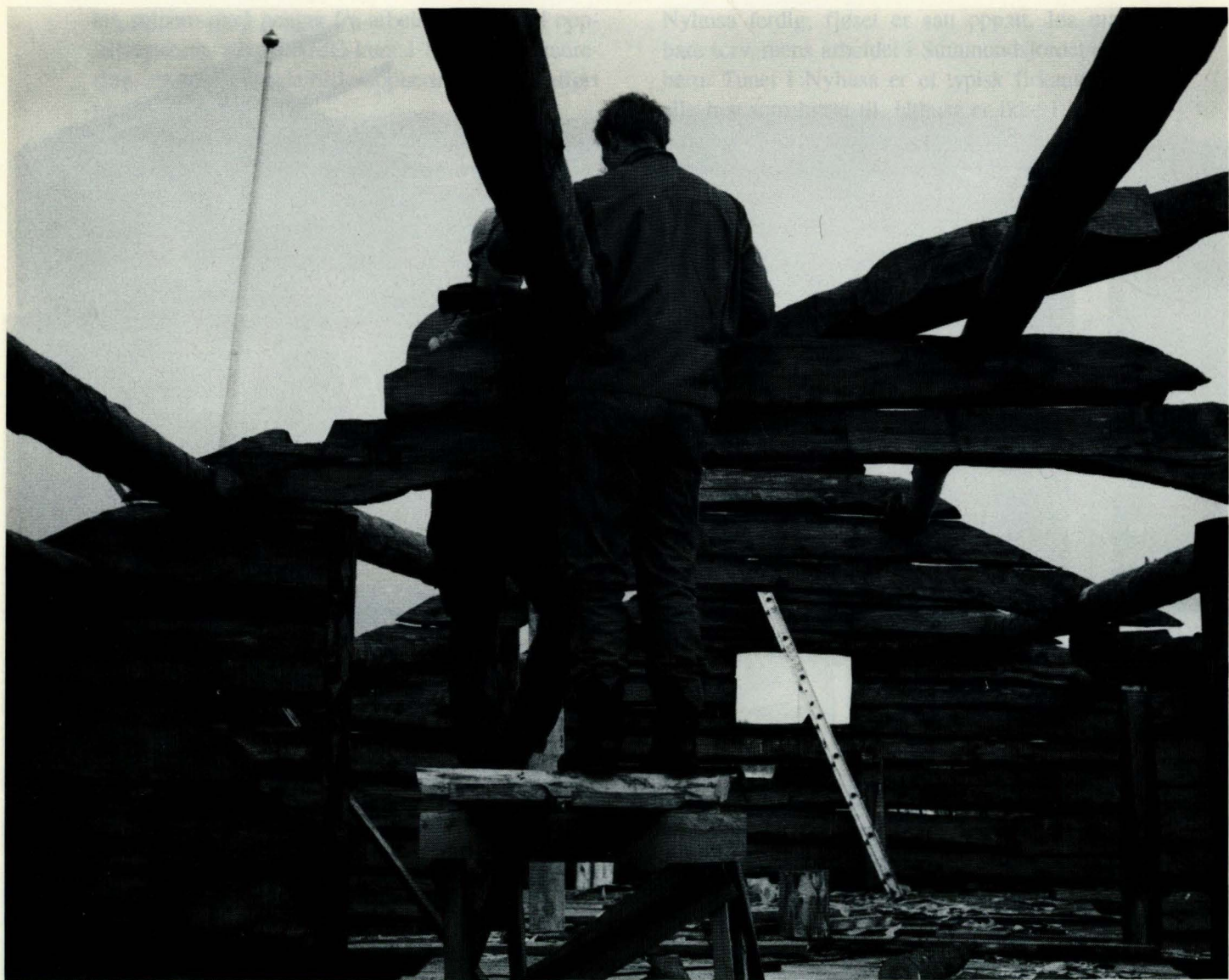
Åsene legges på plass, mye av tømmeret var brukt tidligere, før det ble fjøsløe. (66408).
