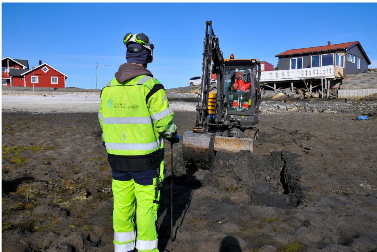
Figur 7 Sven Ahrens stikker med jordbor og viser hvor gravemaskinføreren skal grave. Foto: T. Falck/NMM.
