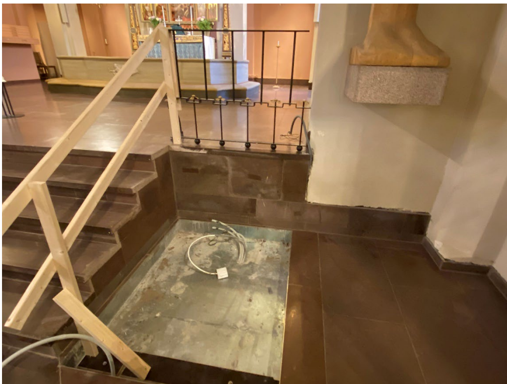
Figur 8. Under pågående arbeten. Stensättningen mot sidorna är färdigställd, liksom gropen för lyftbordet. Foto: 2022-11-25.
