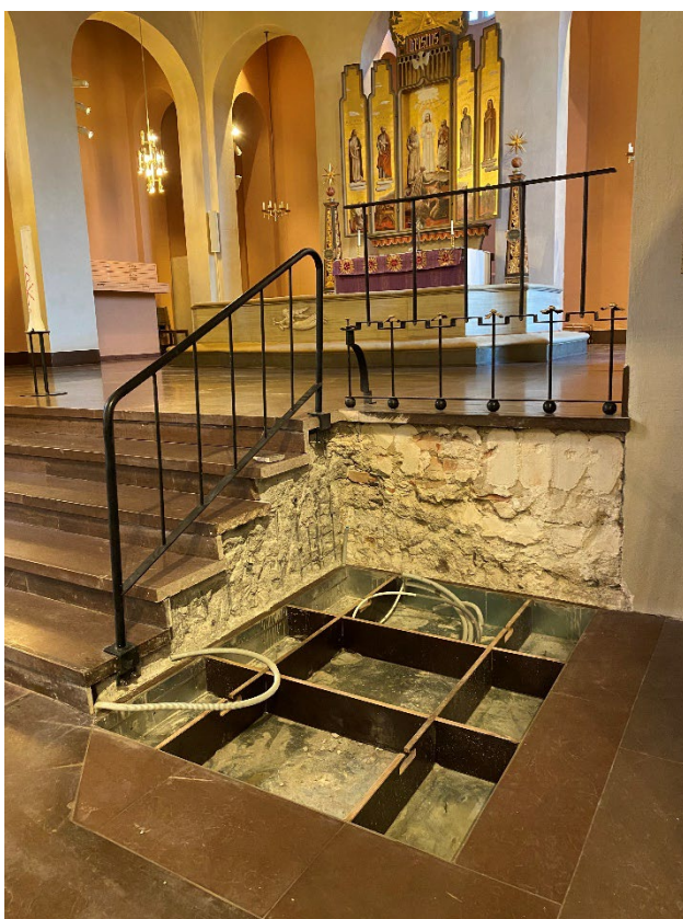
Figur 7. Under pågående arbeten. Gropen för lyftbordet är under arbete. Notera att kalkstenen är lagd för att markera läget för trappan och podiet som har demonterats. Foto: 2022-11-10.
