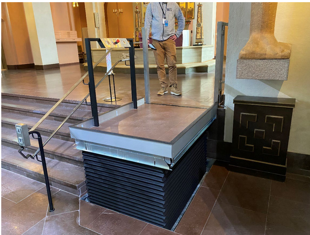
Figur 12. Lyftbordet i det övre stannplanet mot koret. Grinen är uppställd och syns inte på fotot. Skyddsargar fälls automatisk upp när lyftbordet används. Den svarta skyddsbälgen döljer lyftkonstruktionen och minskar risken för infallande smuts samt klämskador. Foto: 2023-02-23.
