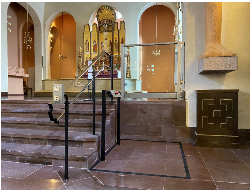
Figur 10. Kalkstenen är lagd i mönster som är anpassat till långhusets stenläggning. Formen för det tidigare podiet markeras genom läggningen av plattor. Inom den svarta gummilisten i golvet rymts lyftbordet. Foto: 2023-02-23.
