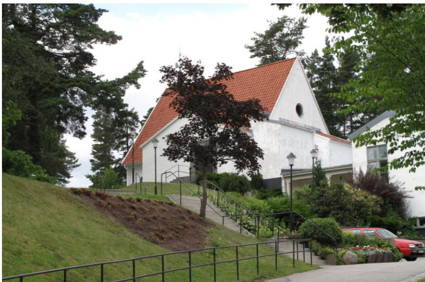
Kyrkan och församlingshemmet som byggdes 1979. Bilden är tagen från p-platsen.
