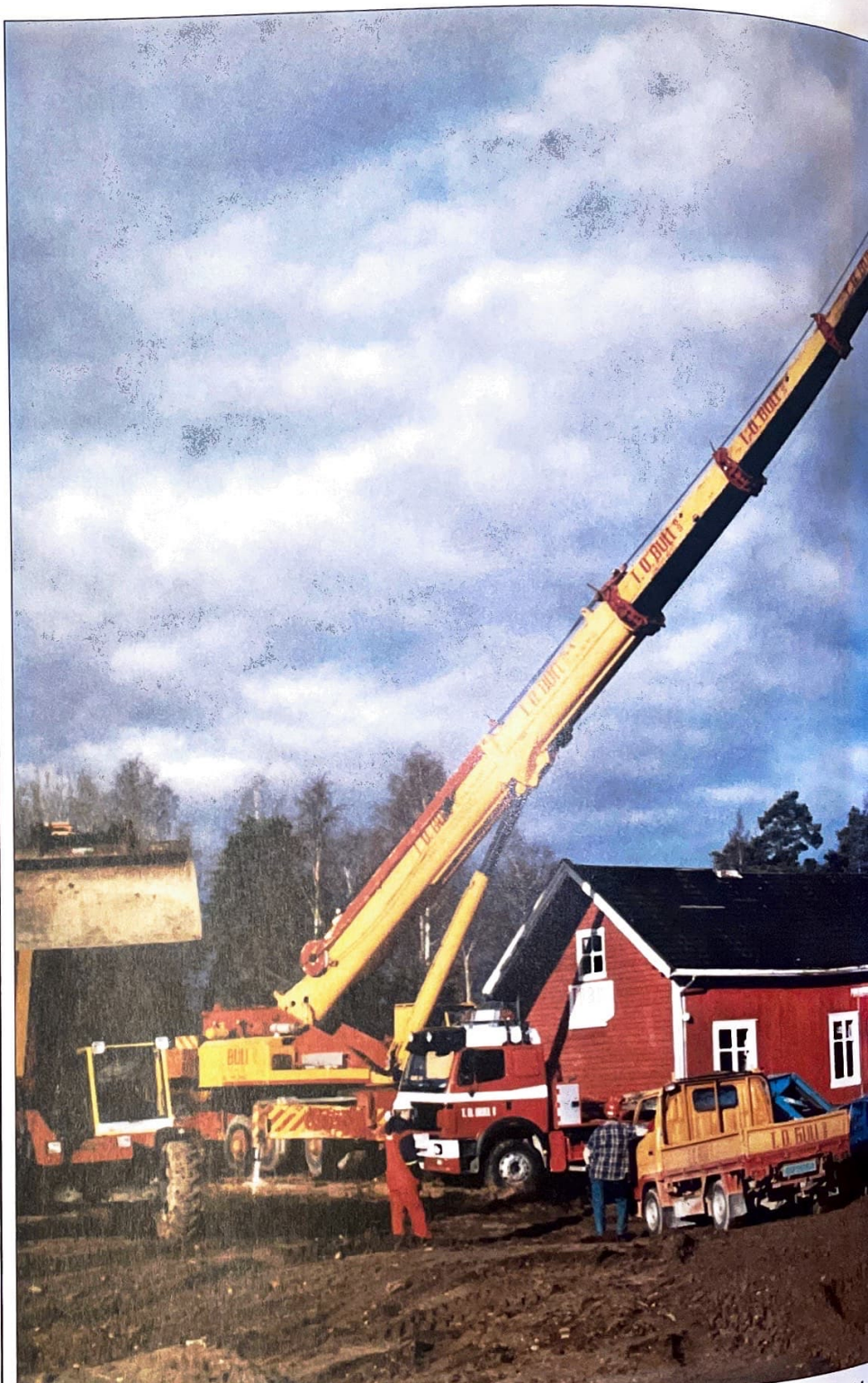
Østerrikegata 13 ble flyttet i ett stykke med unntak av bislagene. Flyttingen foregikk
