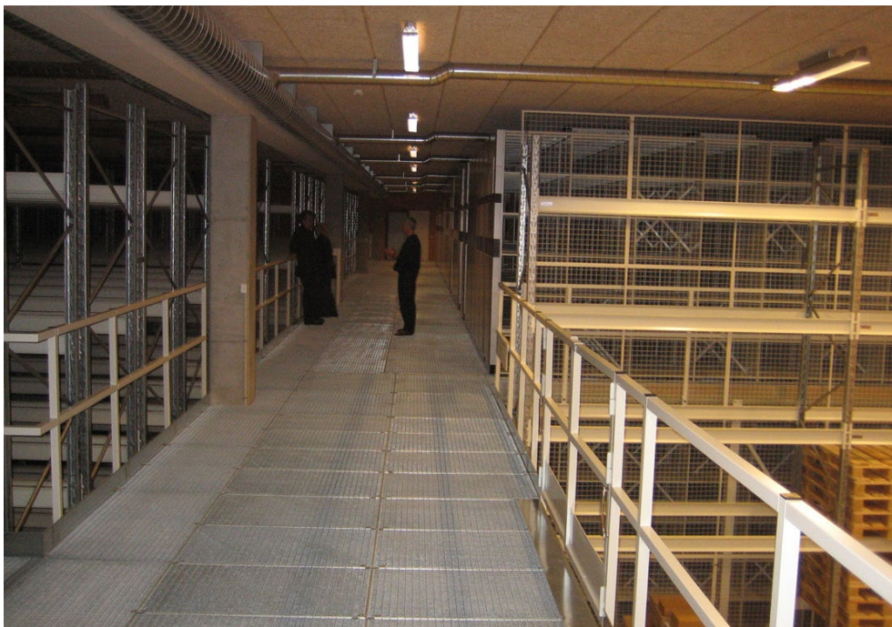
Figur 11. Magasinet i Ribe är 6 m högt invändigt och har en mellanvåning med hyllor och förvaringsenheter. Kanalerna vid innertaket leder in torr luft för att reglera luftfuktigheten på sommaren. Foto: Poul Klenz Larsen.
