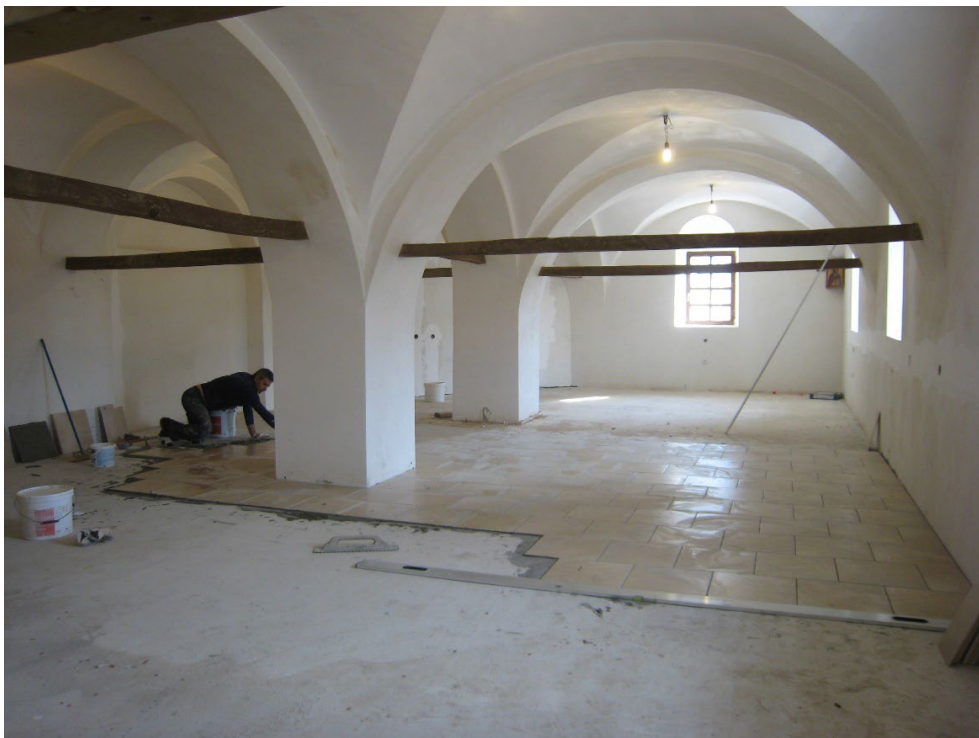
Figur 23. Massiva väggar och tak har en stor termisk tröghet som kan utjämna de dagliga temperaturvariationerna, men inte temperaturförändringen från vinter till sommar. Nya biblioteket, Zografuklostret, Athos, Grekland. Foto: Poul Klens Larsen.
