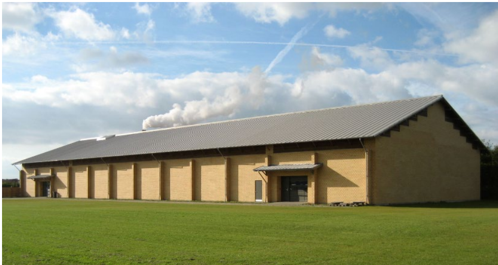
Figur 10. Ett specialbyggt magasin för en kulturhistorisk samling, Ribe, Danmark. Betonggolvet saknar värmeisolering för att möjliggöra värmebuffring. Värmeisoleringen i taket och väggarna är utformad för att temperaturvariationen under året ska vara mellan 8 °C och 16 °C. Foto: Poul Klenz Larsen.
