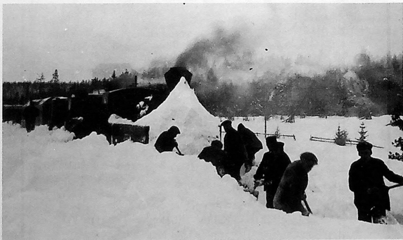
Snøen kunne av og til lage problemer for Urskog-Holandsbanen. Øverst ser vi en sporrenser i virksomhet. Den trekkes av lokomotivet, som ser ut til å være nr. 4 "Setskogen". Nederst spås banen bokstavelig talt frem. Tre lokomotiver har måttet gi opp, og rå muskelkraft må til. (Foto: UHB-arkiv)
