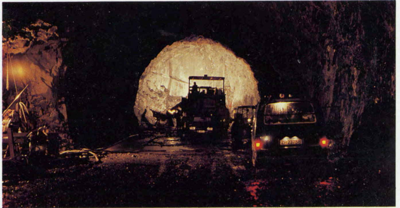
Boring i tunnelen med datastyrt borerigg. Til venstre kjerneboreriggen.
