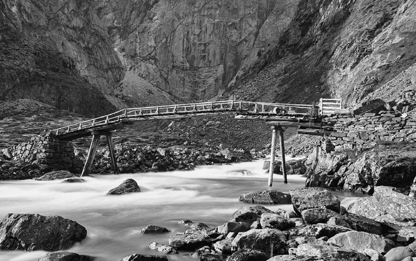
Utlegsbrua over Bjoreia nedenfor Vøringsfossen i Måbødalen i Eidfjord kommune, Vestland, ble bygd av Den Norske Turistforening i årene 1870–1872 som del av en ny turistveg. Brua gjorde det mulig å komme over elva for å se foten av den spektakulære fossen. Like ved brua hadde foreningen mellom 1872–1895 en «bomstasjon», der man krevde penger av de passerende for å finansiere drift og vedlikehold av veggen. Kilde: Bremnes, 1993. Bildet er tatt rundt 1880–1890. Foto: Axel Lindahl/Nasjonalbiblioteket
