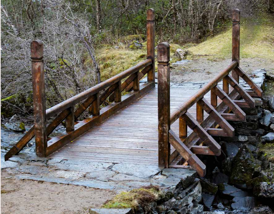
Store Sokni bru, nesten ferdig. Den mangler bare et lag med tjære og utsmykning på de fire endestolpene. De skal, etter Hammers Instrux fra 1794 ha kongens monogram, brunavn, navn på brubygger og årstall. Foto: Jan Adriansen/Statens vegvesen
