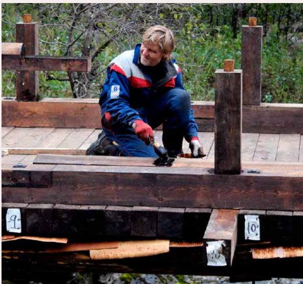
Til venstre: Kjell Stende i byggmesterfirmaet Alle Gode Ting Er Tre smører tjære på stolpehull. Til høyre: Langåsene dekkes med never før støene/utspringerne legges oppå. To tyske wandergessellen var med på brubyggingen, og førte dermed videre en eldgammel tradisjon som også fantes i Norge tidligere. Begge Foto: Jan Adriansen/Statens vegvesen
