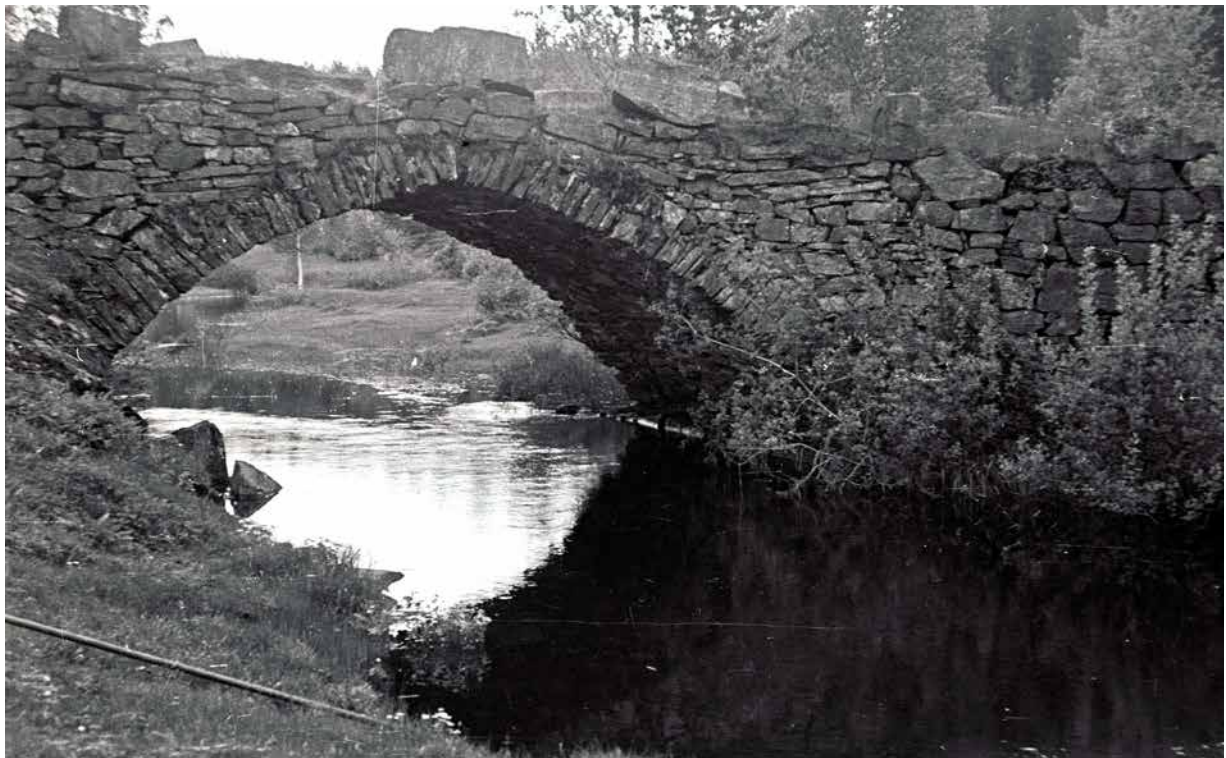
Smedbrua fra 1767 kan være Norges eldste steinhvelvbru. Den går over Fiskumelva på Norges første offentlige vei, Sølveien mellom Kongsberg og Hokksund, bygd rundt 1625. Brua ble fredet alt i 1960. I 1997 ble den åpnet og forsterket med betong på innsiden, en restaureringsmetode vi ikke bruker i dag. Utvendig ble den delvis endret. Øvre Eiker kommune i Viken. Foto: Cato Enger/Riksantikvaren
