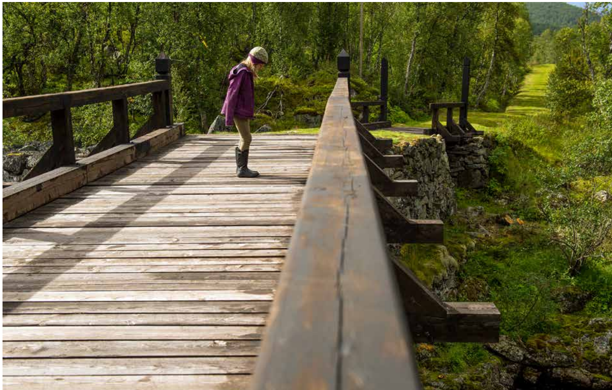
Eksempel på TGO. Nedenfor Maristova, langs Kongevegen over Filefjell i Lærdal i Vestland, er to kongevegbuer rekonstruert og vegetasjonen er rensket. Her er det nok med ordinært vedlikehold for å holde vegeen i god stand. Foto: Sverre Hjørnevik/Kongevegen over Filefjell
