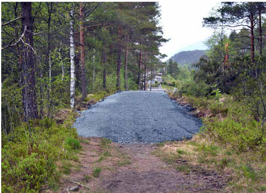
Nytt dekke med maskinknust grus på gammel postveg fra slutten av 1700-tallet endrer opplevelsen av kulturminnet totalt. Den stavangerske postvei ved Gåsakilen på Søfteland i Bjørnefjorden kommune, Vestland. Foto: Sigrun Wølstad/Vestland fylkeskommune
