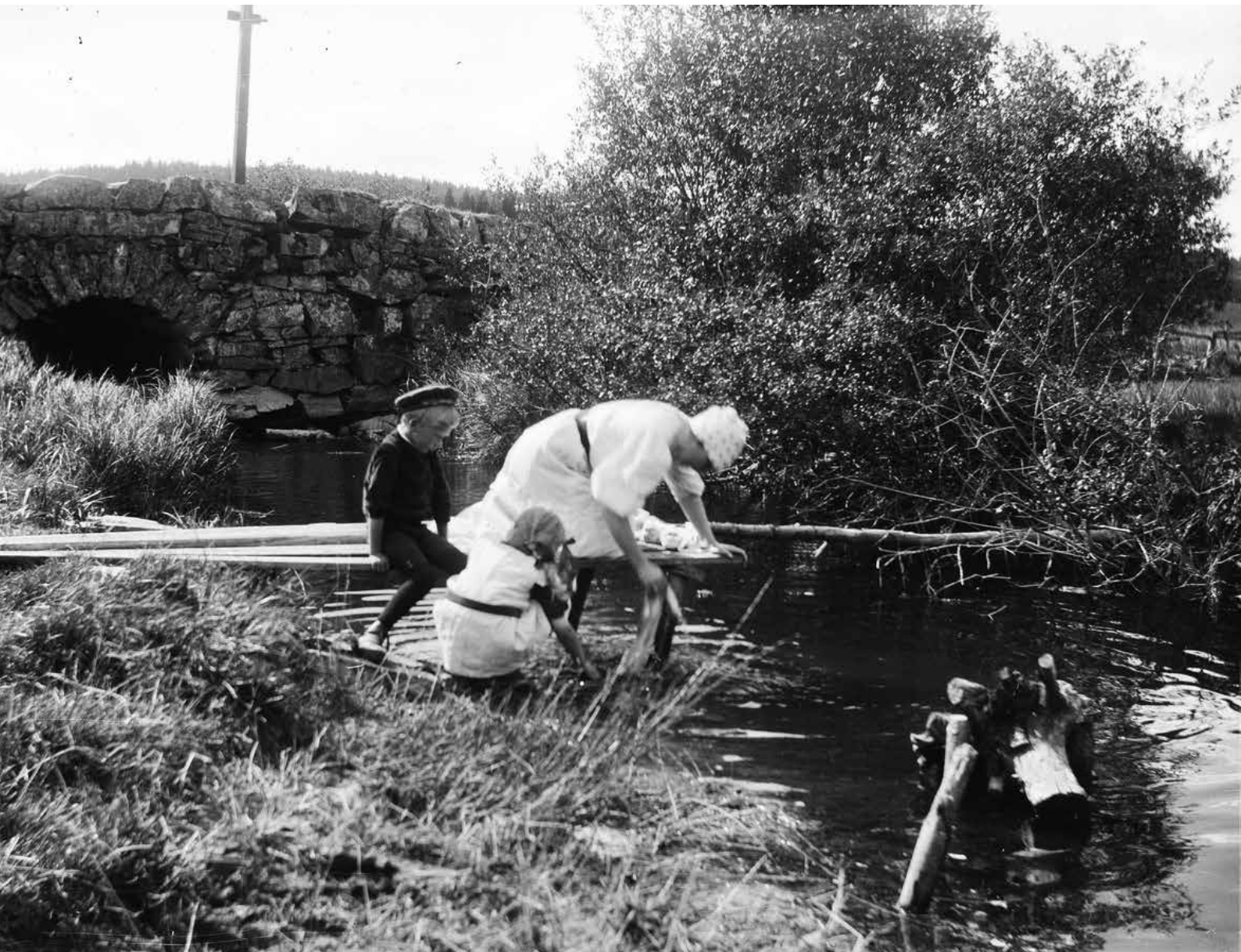
Hammer bru over Losbyelva i Lørenskog kommune i Viken rundt 1910–1915. En lisitasjonskunngjøring (se rammetekst under kapittel 8.13 Klopper og bruer om lisitasjoner) i Morgenbladet 13.11.1839 viser at steinhvelvbrua trolig ble istandsatt rundt 1840. Senere kan den ha blitt reparert eller ombygd. Legg merke til stolpen på brua. Er det et navneskilt, en retningsviser eller en rodemarkering? Dette bildet er i DigitaltMuseum merket med CC (Creative Commons), som betyr at man fritt kan dele og bearbeide bildet. Det eneste vilkåret er at bildet krediteres, og at man forteller hvilke endringer som eventuelt er gjort. I dette tilfellet kan det for eksempel gjøres slik: Foto: Reidar Holtvedt/Oslo Museum, digitaltmuseum.no
