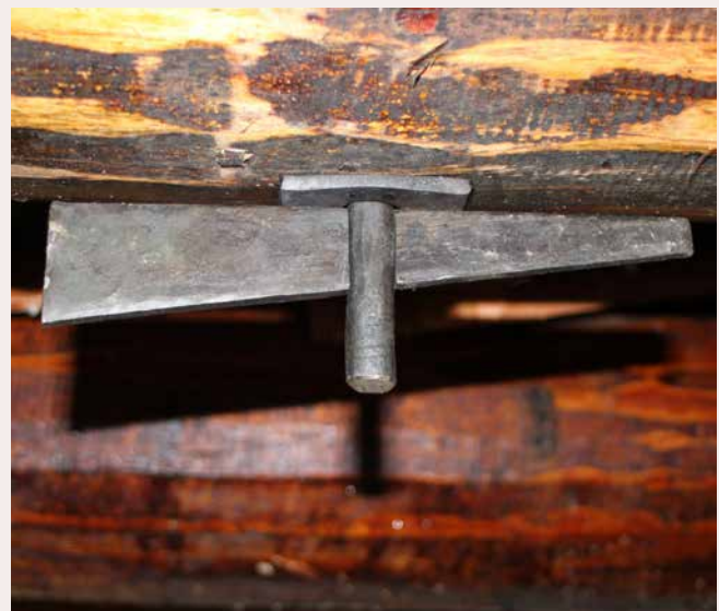
Sålestokkene ble boltet, ikke skrudd fast. Alle bolter og spiker i brua er håndsmidd på smedlinja til Hjerleid Handverksskole. Foto: Bjørn Olav Jaggi/Statens vegvesen
