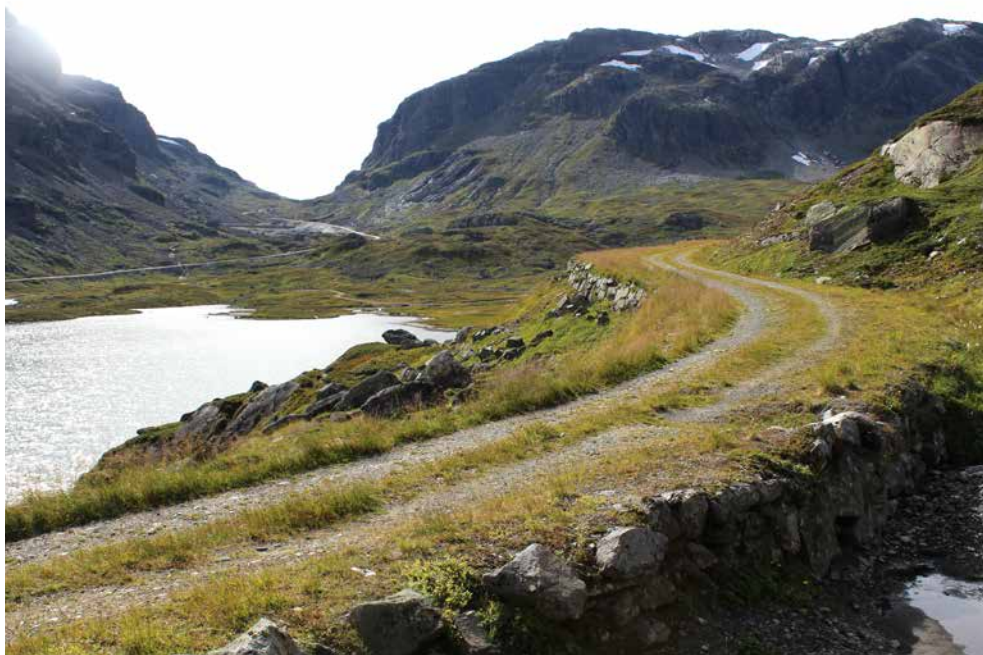
Vegen over Haukelifjell ble bygd mellom 1857 og 1889. Her forbi Ulevåvatnet pågikk arbeidet i 1880-årene. Vinje kommune, Vestfold og Telemark. Foto: Tine Eikehaug/ Statens vegvesen
