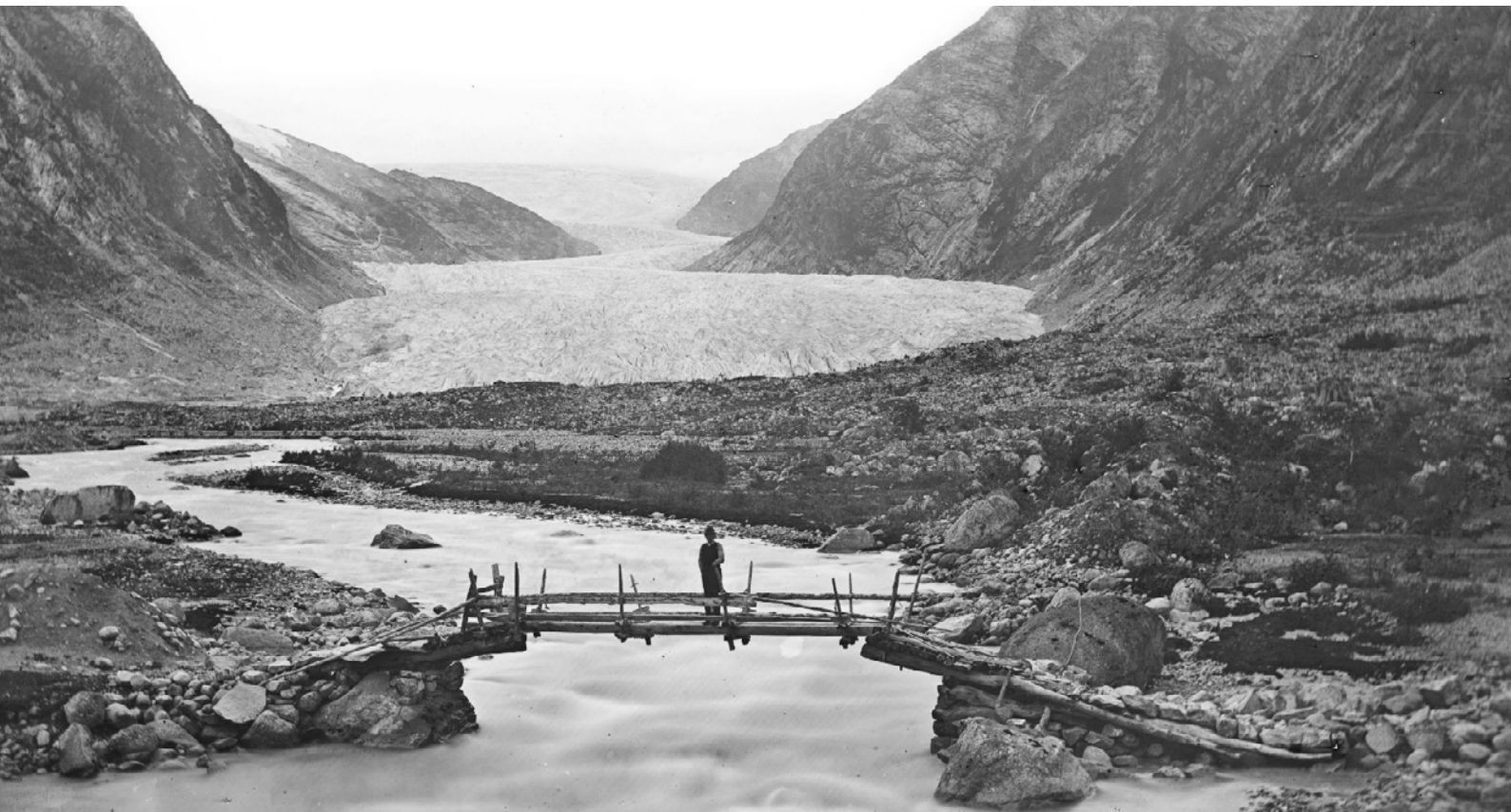
Utleggsbru ved Nigardsbreen i Jostedalen, Luster kommune, Vestland, 1874. En utleggsbru består av tømmerstokker ut fra landsidene, lag på lag og stadig lenger utover elva. På land ble stokkene holdt nede ved hjelp av stein, slik at de ikke tippet ut i elva. Oppå stokkene plasserte man et vegdekke av tre, og ofte rekkverk. Her var lengden over elva såpass liten at det bare var nødvendig med ett lag tømmer i utlegget. Foto: Knud Knudsen/Universitetsbiblioteket i Bergen
