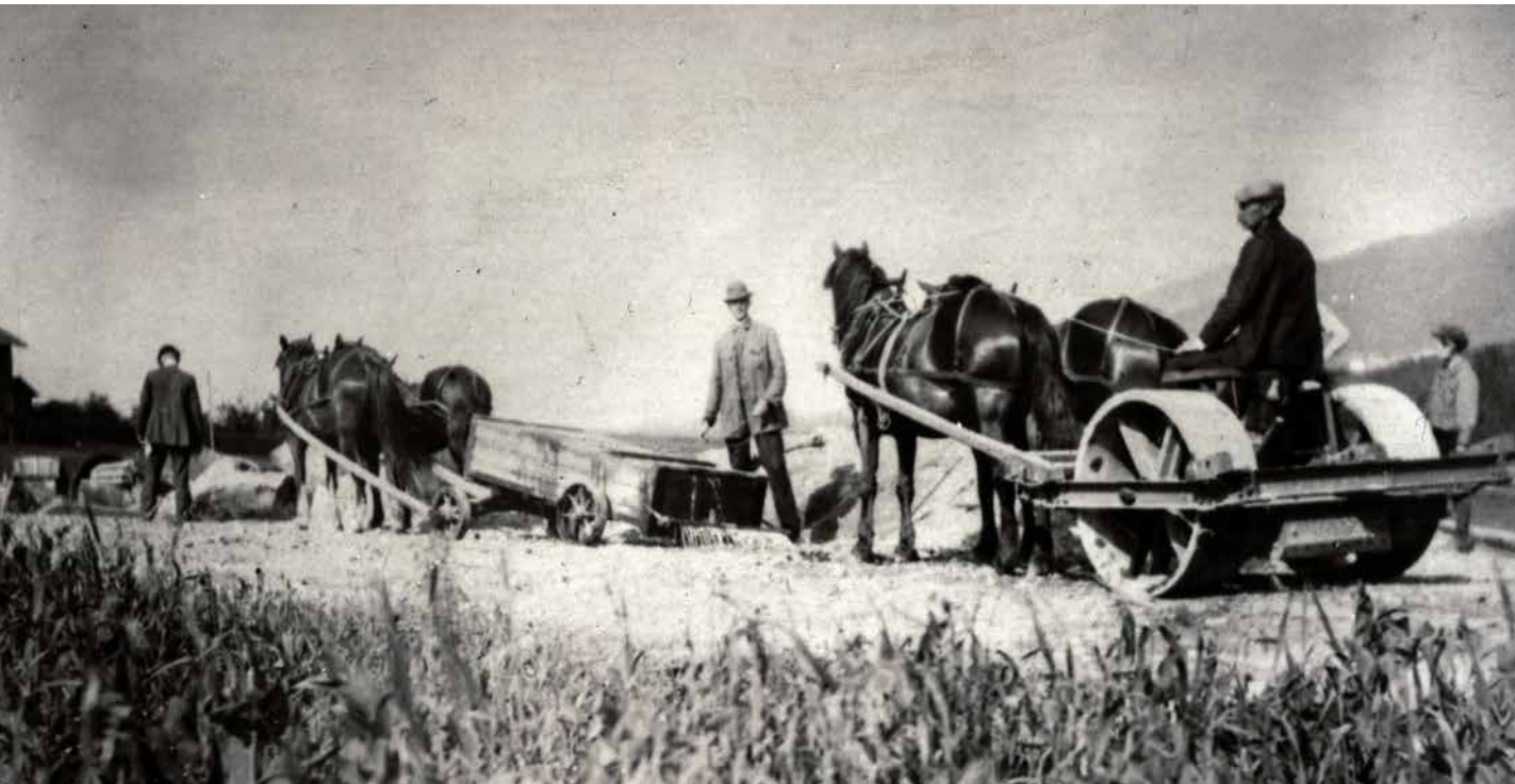
Vanning og komprimering av vegdekke med vannvogn og vegvalse trukket av hester omkring 1909. Trolig ved Åmot i Modum kommune i Viken. Ukjent fotograf/Norsk vegmuseum (redigert)
