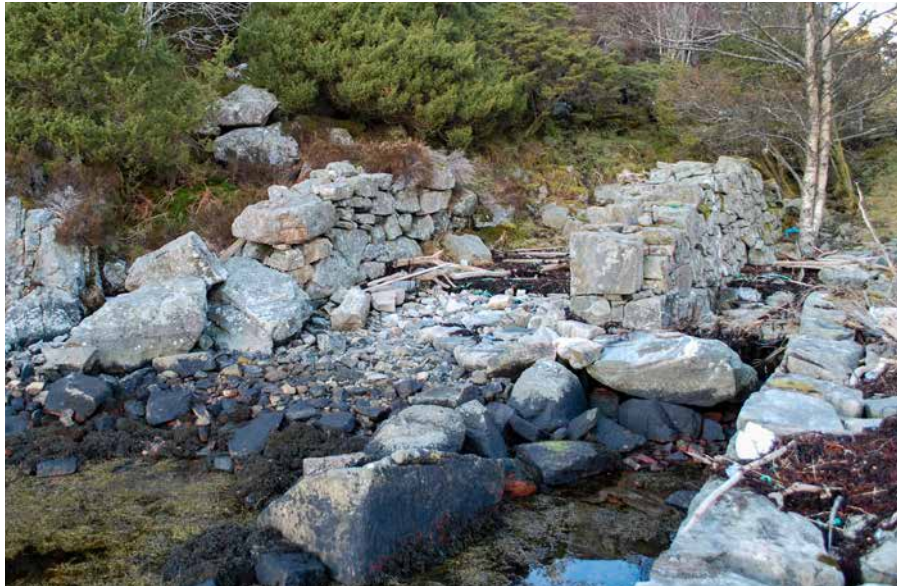
Der de gamle vegene kombinerte landvegen med strekninger over vann, var det noen ganger egne naust til båten man brukte. Dette postvegnaustet i Postvågen i Gulen kommune, Vestland, tilhørte Den trondhjemske postvei mellom Bergen og Trondheim. Postvegbyrgga sees til høyre. Foto: Tine Eikehaug/Statens vegvesen
