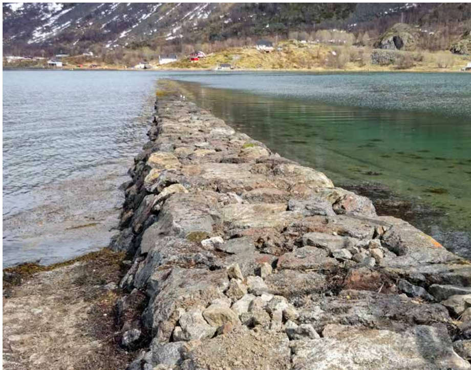
Den 180 meter lange steinbrygga (båtvorren) i Øksfjord i Loppa kommune i Finnmark, kalles lokalt for Moloen, og ble bygd i 1910, som enden på et vegprosjekt. Lengden gjør at man kunne fortøye ved den i både flo og fjære, og den kunne romme mange båter. Foto: Anlegg Nord AS
