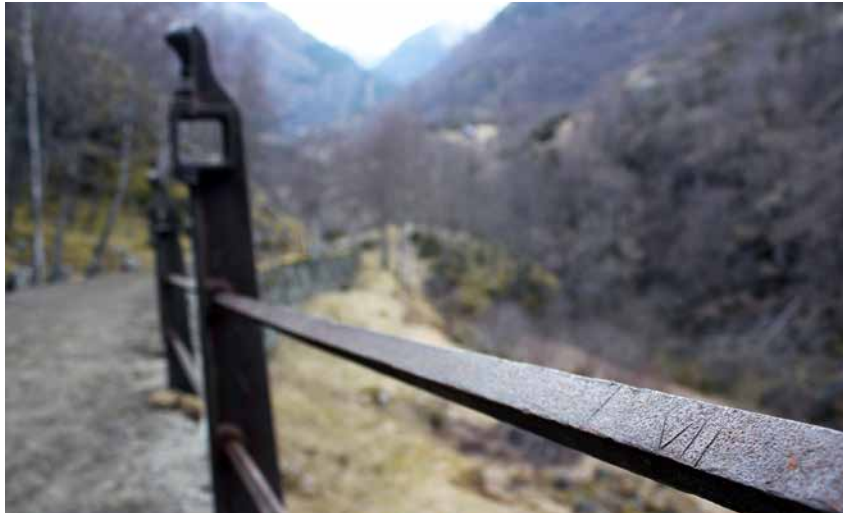
Rekkverket i Vindhella i Lærdal kommune i Vestland, langs Den bergenske hovedveg, ble satt opp rundt 1846. Siden rekkverksstolpene ble satt opp for hånd, varierer de litt i avstand. For å være sikker på å treffe rett, merket man derfor listene mellom dem med nummer. Små, men viktige detaljer i kulturhistorien til vegen. Foto: Jan Adriansen/ Statens vegvesen
