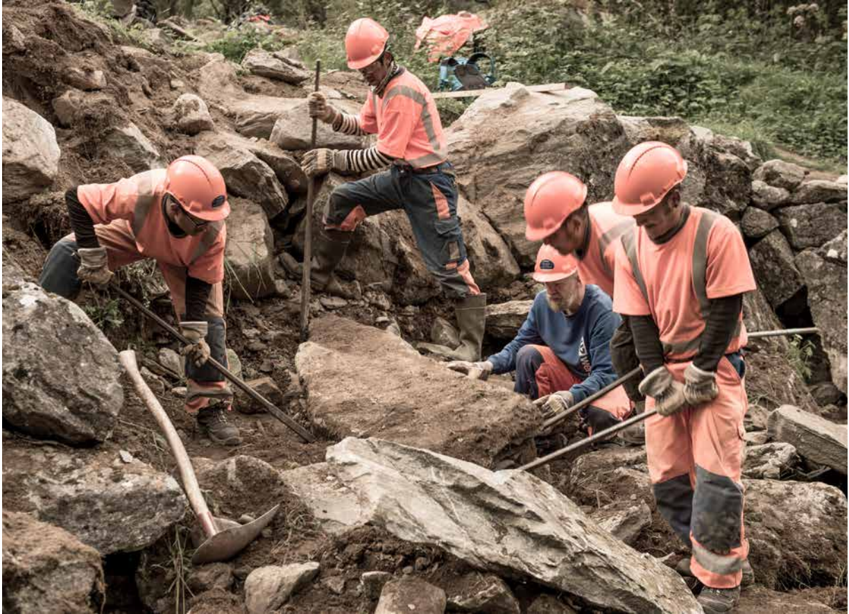
Hjelm, vernehansker, vernesko og riktig bruk av verktøy må til for å redusere faren for skader. Galdane, Lærdal kommune, Vestland. Foto: Sverre Hjørnevik/Kongevegen over Filefjell
