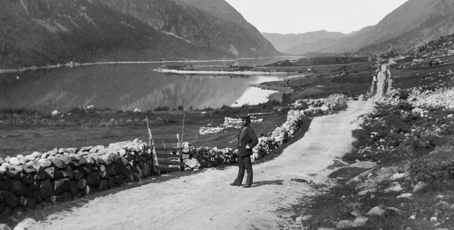
Steingard i kistemur langs veg i Grungedal i Vinje kommune i Vestfold og Telemark, i 1871. Foto: Knud Knudsen/Universitetsbiblioteket i Bergen (redigert)
