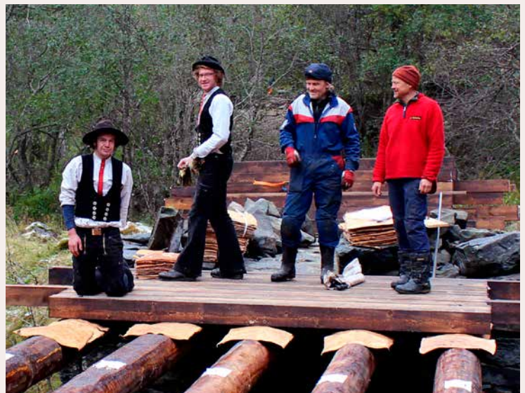
Til venstre: Kjell Stende i byggmesterfirmaet Alle Gode Ting Er Tre smører tjære på stolpehull. Til høyre: Langåsene dekkes med never før støene/utspringerne legges oppå. To tyske wandergessellen var med på brubyggingen, og førte dermed videre en eldgammel tradisjon som også fantes i Norge tidligere. Begge Foto: Jan Adriansen/Statens vegvesen
