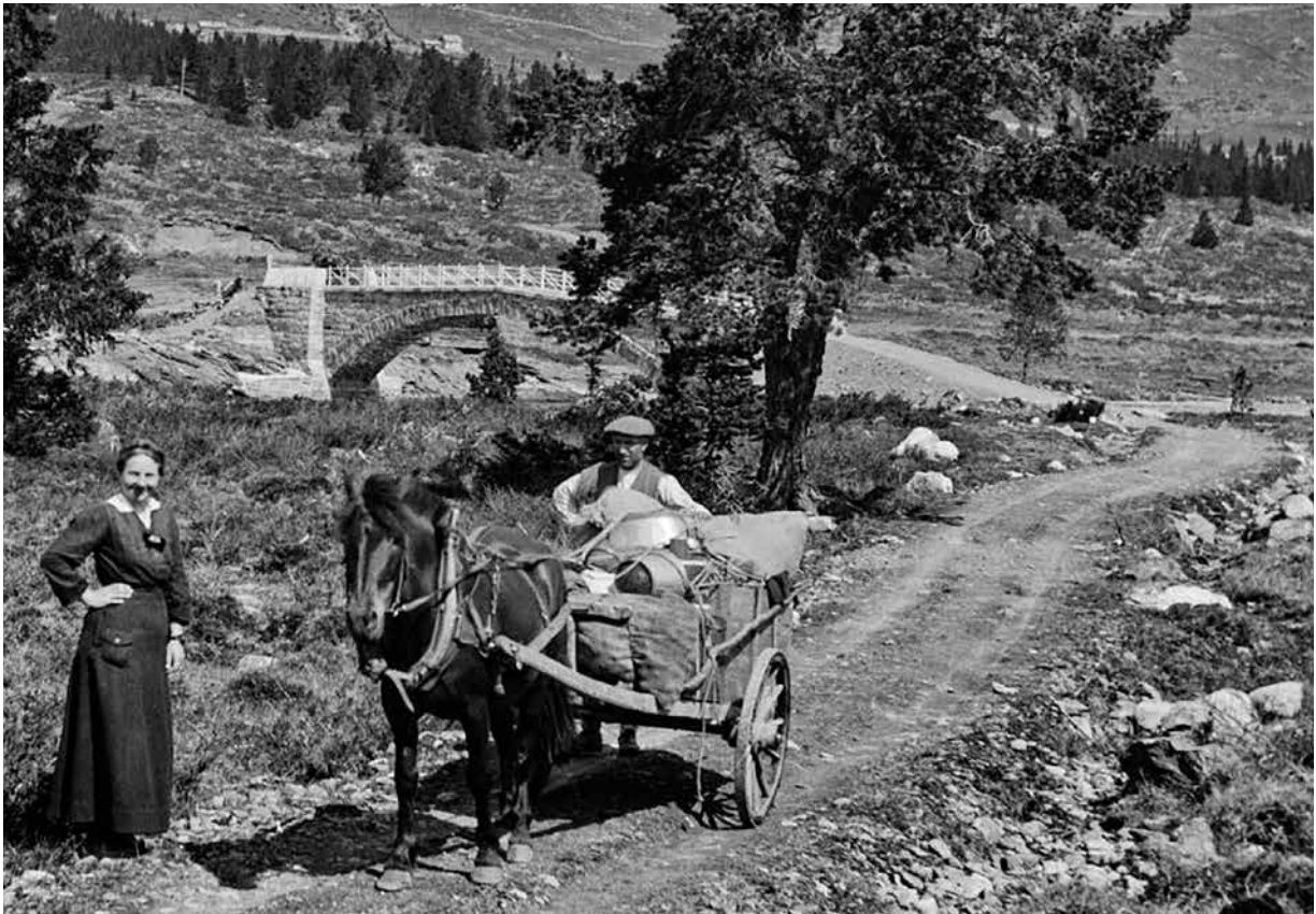
Mange veger er laget bare med fyllmasse, uten støttemurer av stein på utsiden. Da består vegmassen oftest av sand eller grus og stein. Foto: Lauritz Johan Bekker Larsen/Universitetsbiblioteket i Bergen (redigert)
