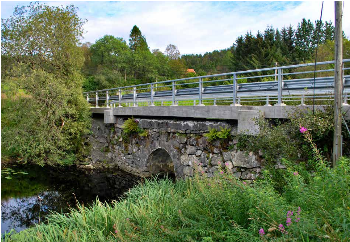
Steinhvelvbrua Hundvin bru i Alver kommune, Vestland, langs Den trondhjemske postvei, ble satt opp i 1912 og erstattet da en eldre bru. I 2015 la man en ny betongplatebru oppå den gamle. Kan dette sees på som en grei, alternativ løsning eller er det bare skjemmende og skadelig for kulturminnet? Foto: Kjersti Tidemansen/Statens vegvesen
