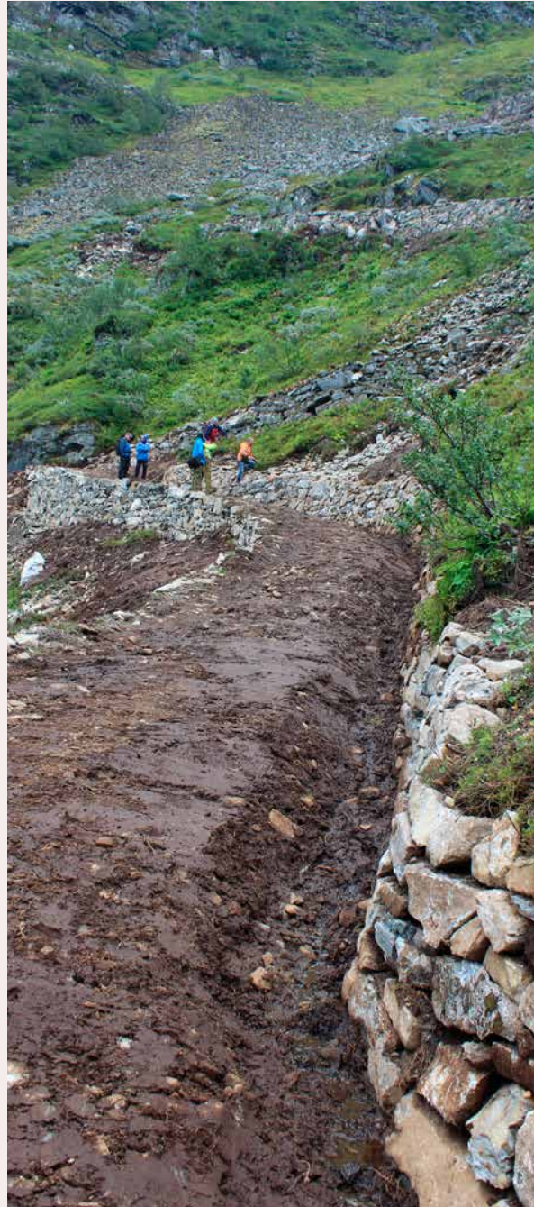
Den opprinnelige vegen hadde verken mur på innsiden eller spor etter dreneringsgrøft i dette partiet. Foto: Jan Adriansen/Statens vegvesen
