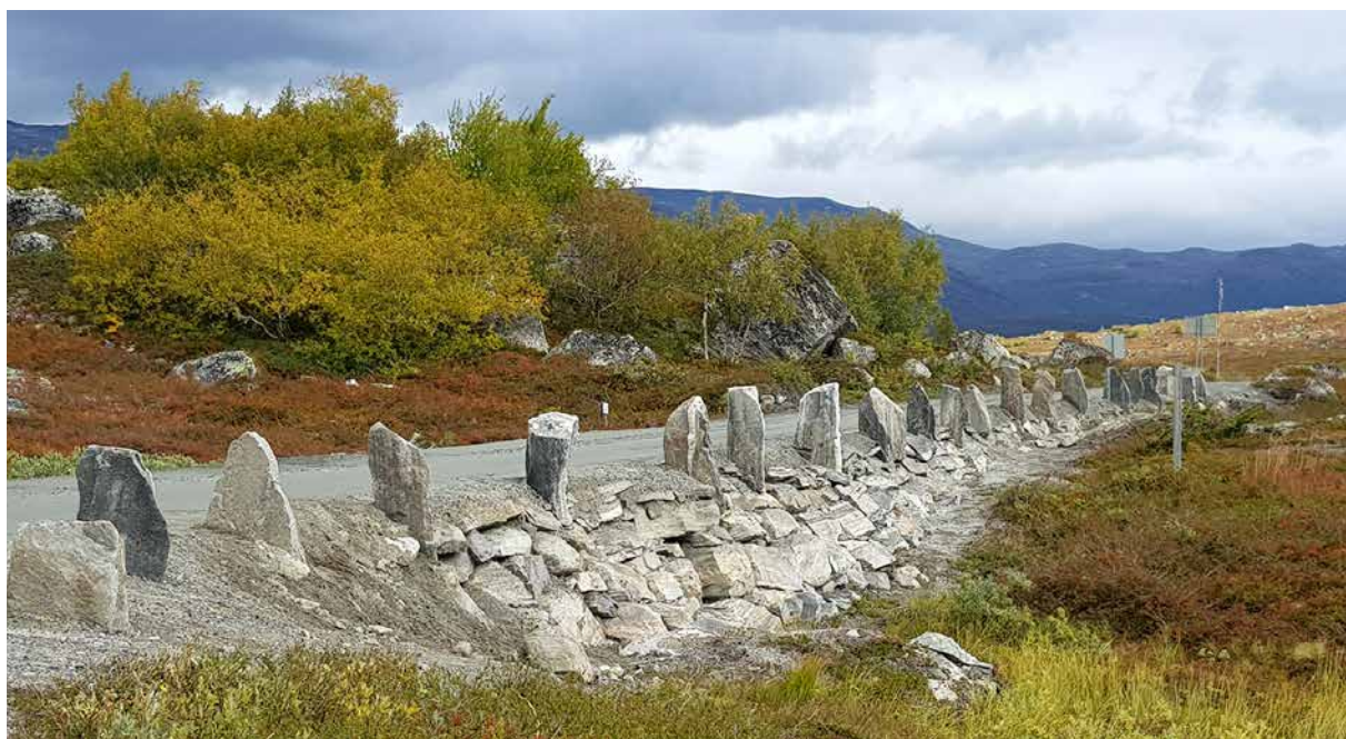
Gamle Strynefjellveg fra 1884 blir jevnlig gruset, men snøbrøyting og annet gjør at mye av grusen havner på sidene av vegen. Vegmurene var helt dekket før Statens vegvesen i 2019 gjorde en stor oppryddingsjobb og fikk fram de gamle murene igjen. Her fra Skjåk kommune, Innlandet. Foto: Ann Kristin Engh/Statens vegvesen
