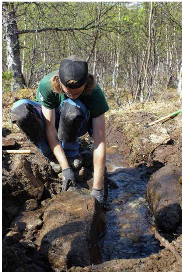
Erfaringene fra prosjektet Kongevegen over Filefjell, viste at gjennomsnittsprisen for å bygge opp igjen en kollapset stikkrenne lå på om lag 25 000 kr i 2014. Dette inkluderte transport til startstedet og vandring til og fra arbeidsplassen (som på fjellet kunne være opp til 5 km hver veg), fjerning av masse, opptaking av nedfallsstein, oppbygging av stikkrenne, tilbakelegging av løsmasse og plastring av området. Lærdal kommune, Vestland. Foto: Jan Adriansen/Statens vegvesen
