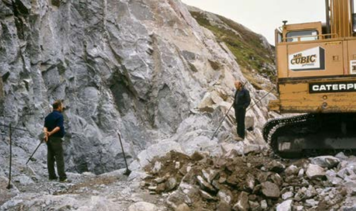
Påhugg for toppen av en lukesjakt. (Foto: Petter Odlang)
