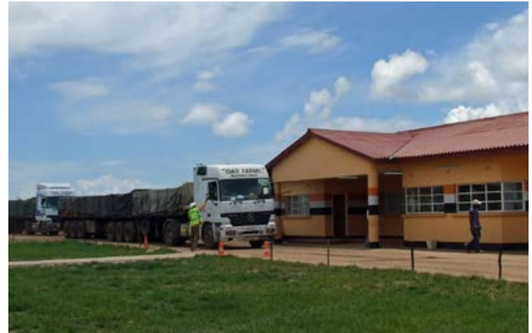
Statens vegvesen bidrog med kompetanse i planlegging og utbygging av til saman ni vektstasjonar i Zambia, finansiert av Norad med støtte fra blant andre EU, Danida og Verdsbanken.
