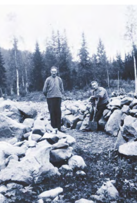
Stenbrydning og oprydning af sten på Åsethagen, Ringsaker. Dato ukendt. (ID O412-08644)
