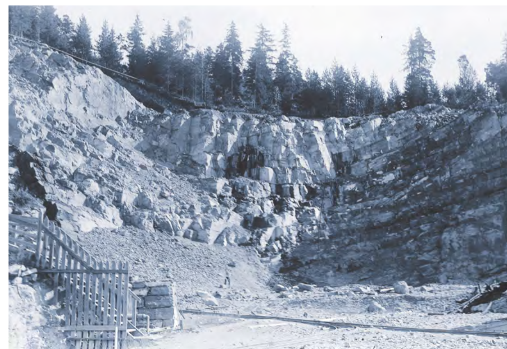
Sprængt kalksten, Steens kalkbrenneri, Furuberget. Foto fra perioden 1917-1940. (ID HHB-02216)
