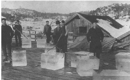
**Eisblöcke vor der Verladung in der Nähe von Kragerø (ca. 1900).** Der Transport der Blöcke erfolgte mittels eines ausgeklügelten Systems von Gleitbahnen, so dass ein manuelles Heben der Blöcke weitgehend vermieden wurde. Dennoch gab es spezialisierte Greifzangen und Eishaken, die sowohl für den Transport an Land wie auch zum Stauen an Bord der Schiffe genutzt wurden. Sammlung Berg-Kragerø Museum, Kragerø
