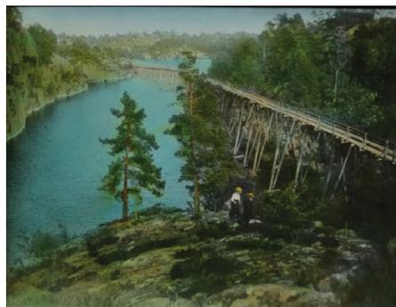
**Für den Transport der Eisblöcke errichtete Gleitbahn bei Stabbestad, Kragerø.** Die Länge der Gleitbahn zeigt eindrucksvoll die teils aufwendige Infrastruktur, die für den Transport des Eises von den zur Eisproduktion genutzten Gewässern zu den Verladestellen unmittelbar am Fjord angelegt wurde (ca. 1900). Photo: John Lyng-Olsen, Lyng Olsen Sammlung Berg-Kragerø Museum, Kragerø
