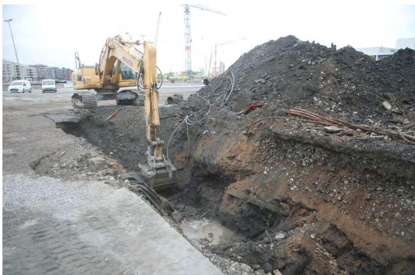
Figur 10: Forgraving til spuntene rundt tomt B2. Foto av Kjetil Bortheim, NMM.
