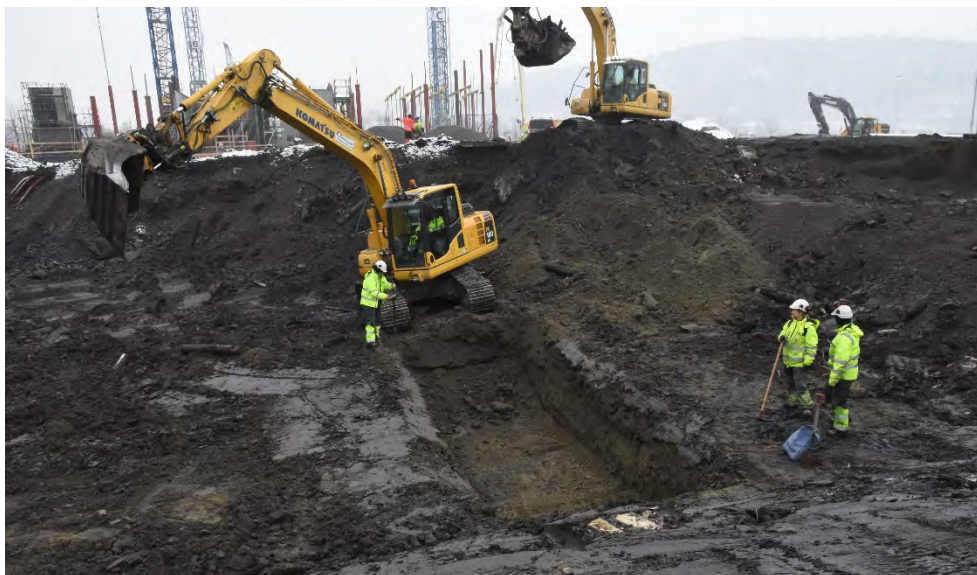
Figur 13: Graving og dokumentasjon av inspeksjonsgrøft. Foto av Kjetil Bortheim, NMM.
