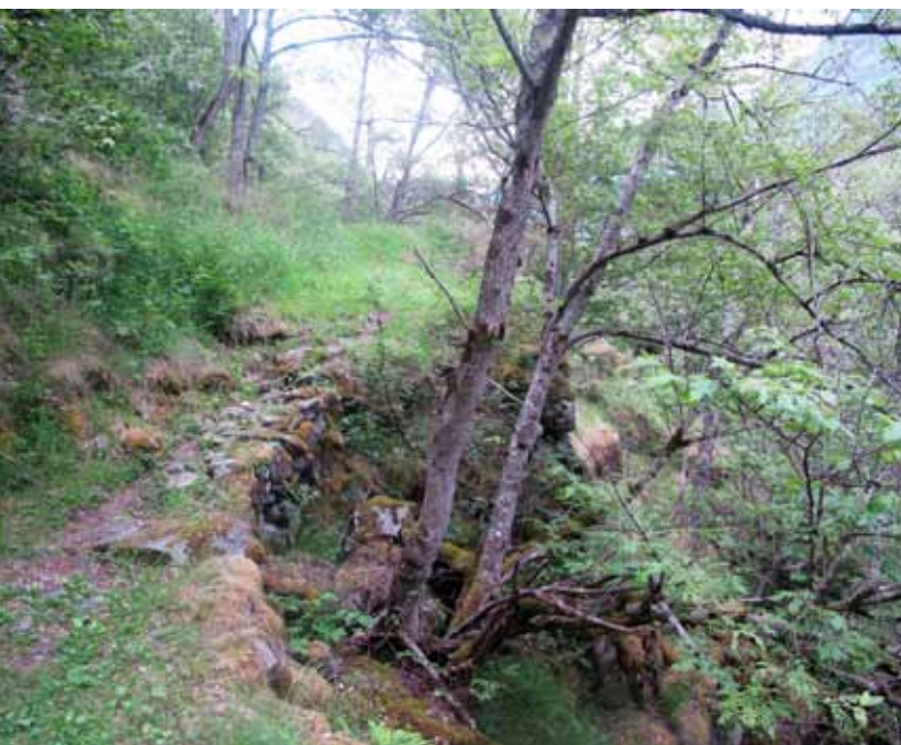
Mer enn halve vegens bredde har rast ut. (Foto Jan Adriansen)
