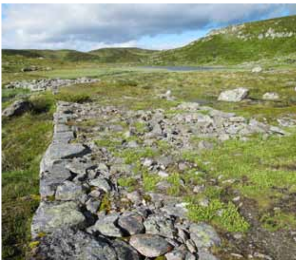
På steder der topplaget i dag er borte, kan vi se hvordan vegkroppen er bygget; oppløftet i terrenget, avgrenset og kantsatt med steinmur og ifyllt mindre stein. Oppå dette ble det lagt organisk materiale som jord og grus. Hammer poengterer at underlaget ikke måtte komme til syne, og at veg- banen måtte være høyere på midten enn ut mot sidene pga avrenning. (Foto Hanne Johnsrud)
