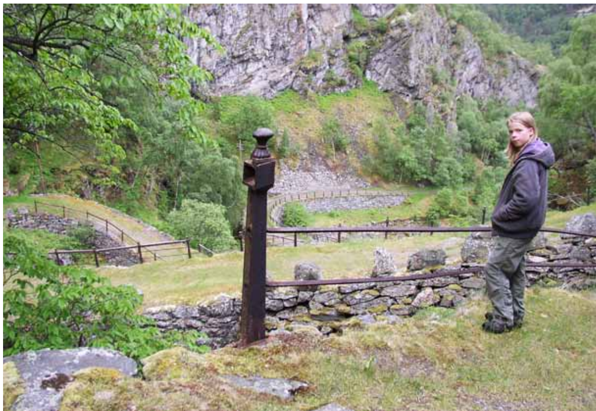
Vindhellavegen er et unikt byggverk, tilpasset og formet inn i det trange skaret; først Kongevegen i 1793, deretter kaptein Finnes elegante hårnålssvinger i 1840-årene. (Foto Jan Adriansen)
