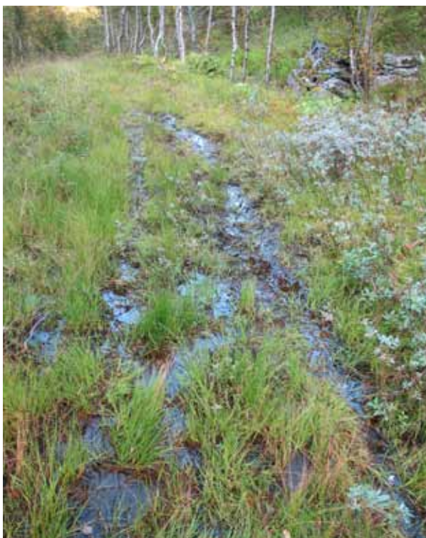
Gjengroing og dreneringsproblemer er stikkord for hele strekningen langs Fløkstrøndfjorden, og som her, i Hølabakken. (Foto Tine Eikehaug)
