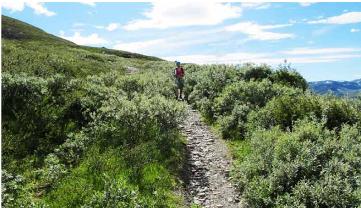
Også på høyfjellet, der naturen vokser sakte, er vegen og grøftene i ferd med å forsvinne helt under all vegetasjonen. Her har vannet gravd nytt løp midt i vegbanen. (Foto Hanne Johnsrud)
