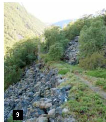
I det bratte partiet mellom Borloshagen og Ulviksbakken er Kongevegen bygd gjennom ura. (Foto Hanne Johnsrud)
