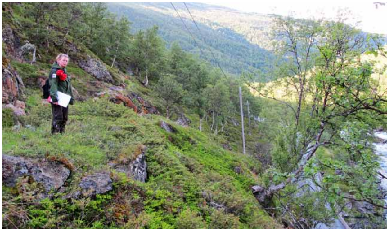
Ved Raudgalden slutter Kongevegen brått. Terrenget her er bratt og styrter rett ned mot elva og dagens E16. Kildene forteller at her var Kongevegen lagt på stokker festet til fjellet, på såkalte «hengebroer». Kan hende må det nye «hengebroer» til for å kunne passere videre? (Foto Hanne Johnsrud)
