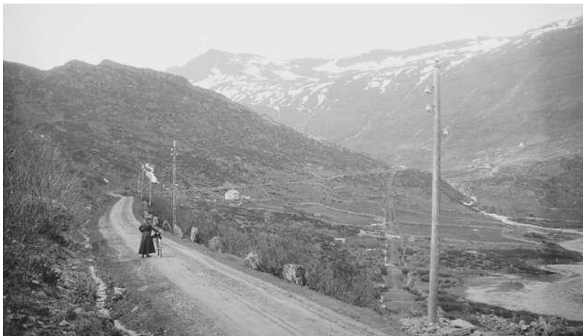
Ved Øygardsjordet ser vi den nye vegen (til venstre) følge høydedraget i terrenget, mens Kongevegen går rett fram med lange bakker opp og ned. (Foto Anders Beer Wilse, 1907).
