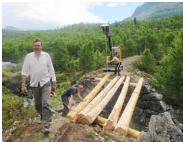
Ved Honingane bygges gamle Honing bru opp etter gamle prinsipp. Kåre Hovland (t.v) i Lærdal kommune har vært drivkraften bak prosjektet. (Foto Jan Adriansen)
