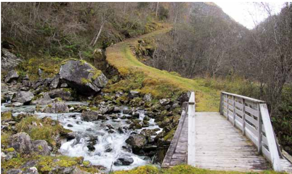
I Soknegalden er vegmuren ut mot dalsiden i ferd med å rase ut. Det mørkegrønne feltet nedover bakken viser et søkk i vegen der yttermuren siger sakte, men sikkert, utover. (Foto Tine Eikehaug)
