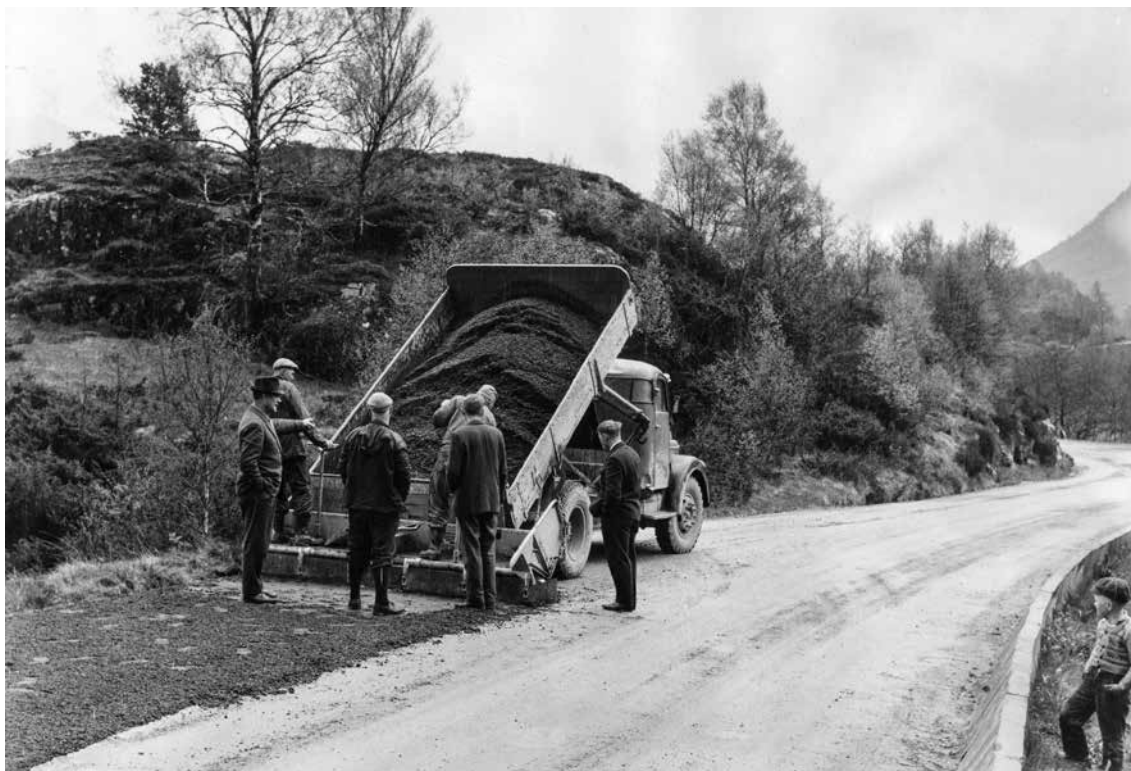
Da Kjell Levik startet i Statens vegvesen var det "fast dekke" et folkekrav i store deler av landet. Asfaltbransjen vegret seg mot oljegruslegging, de ville legge asfalt i stedet. Dermed ble det startet oljegruslegging i egen regi. Dette bildet er fra første gangs utlegging av oljegrus fra eget verk i Ryfylke i 1964. (Ukjent fotograf, trolig for Stavanger Aftenblad)
