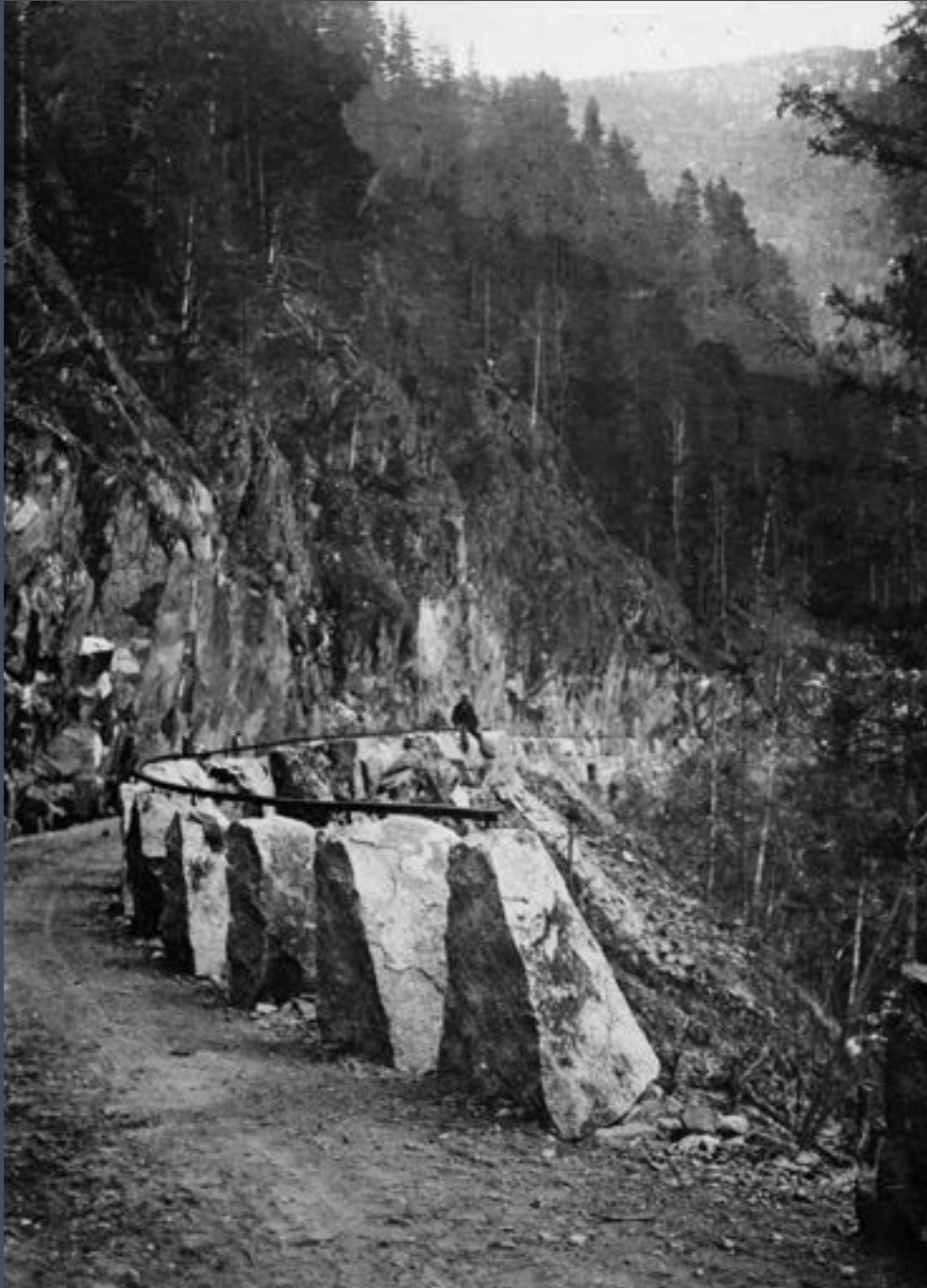
Et tidlig stabbesteinrekkeverk, bestående av en jernstand boltet til oppsatte stabbesteiner langs vegen, fra Vaatekleiven på veganlegget Dalen - Mo - Vinje i Telemark. Bildet inngår i samlingen "Vegdirektørens fotoalbum", bilder fra ulike veganlegg og vegmiljøer fra 1850 til 1924.
