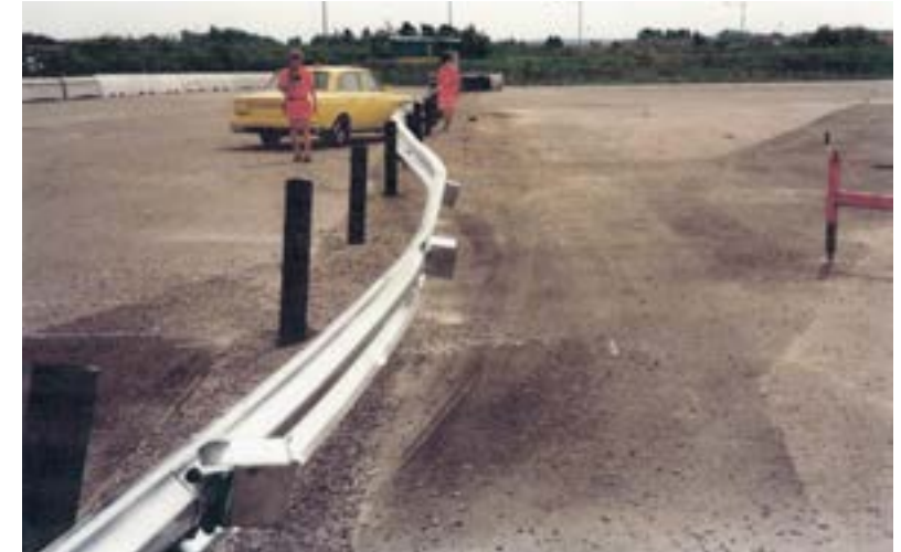
Bil og rekkverk etter test av plaststoelper ved VTI. (Foto: Arnulf Ingulstad)
