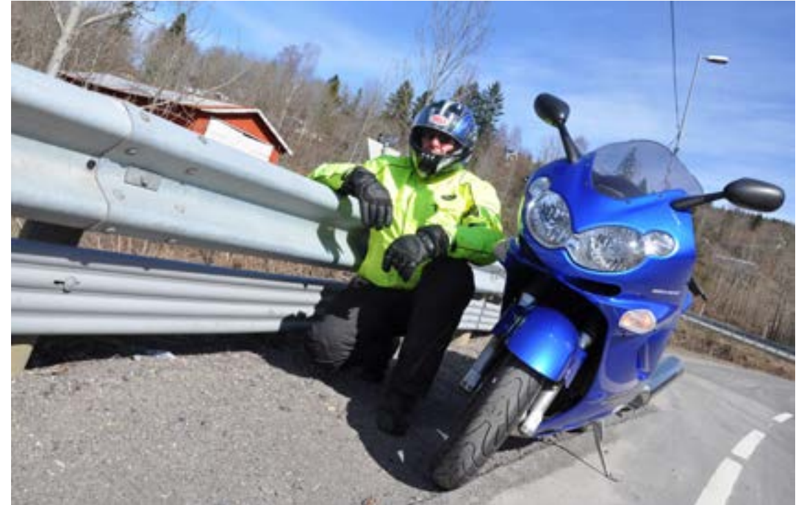
Den 24 cm brede underskinne for motorsykler ble bl. a testet ut på den viktige turveien fv 32 Skien - Siljan i Telemark. Motorsyklist Jan Petter Lyng var veldig godt fornøyd på bildet fra 2010. (Foto: Kjell Wold)
