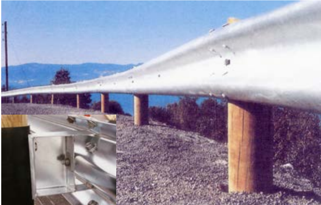
Rekkverknormalene fra 1968 stilte krav om W-stålskinne med A profil. (Foto fra Håndbok 166) Innfelt, utblokkingsbøyle for montering mellom stålskinne og stolpe. (Foto: Arnulf Ingulstad)
