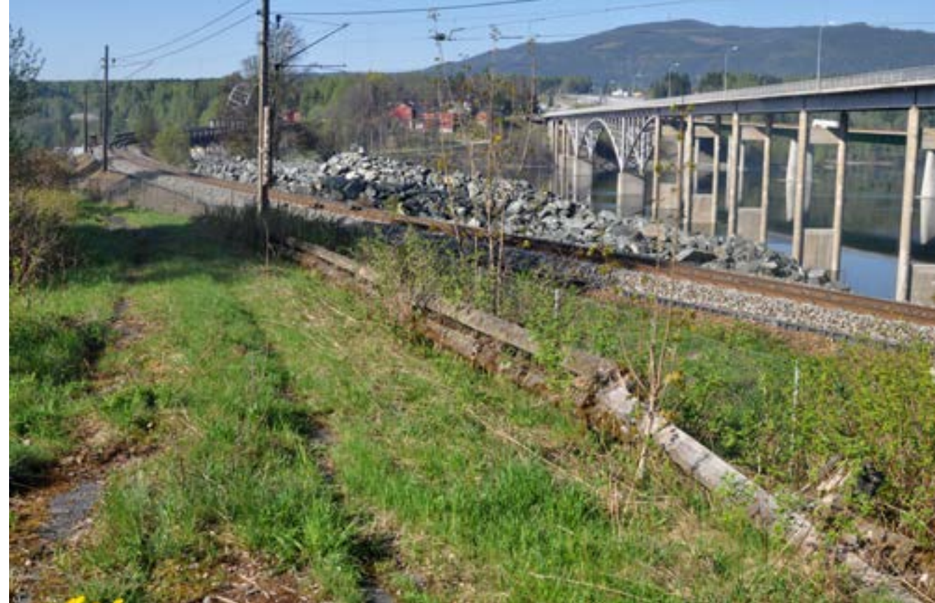
Rester av Saxegård's skrårekkverk er fortsatt synlig ved Minnesundbruene. Vegen her kom opp fra den første vegbrua, dvs to konstruksjoner hengt på hver side av jernbanebrua (bygd i 1879 og gitt dagens imponerende midtspenn i 1913). Denne løsningen og dette rekkverket var i bruk fra 1925 og frem til den nye Minnesundbrua, i dag Langset bru til høyre, kom i 1959. (Foto: Håkon Aurlien).
