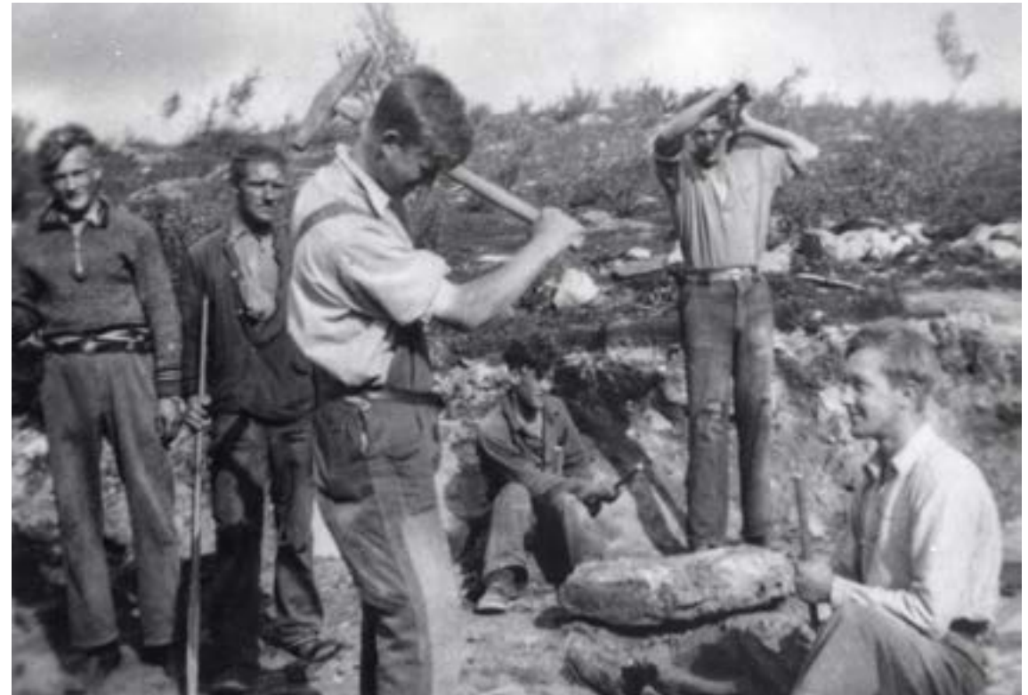
Nødsarbeid. Ungdomsarbeidsløshet var et samfunnsproblem i mellomkrigstiden, og det ble satt i gang egne tiltak blant annet i Finnmark. Her ser vi et arbeidslag i 1939 ved grunnmursmuring på strekningen Smørfjord - Kokelv.
