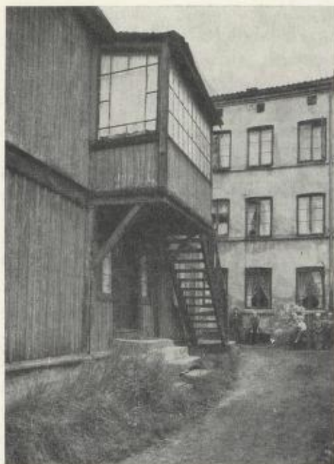
Murgården bakom Stolmakergt. 5 ligger litt friere og lysere enn de fleste bakgårder. Den er bygd omkring 1870. Det er ikke svære greiene: ett rom og kjøkken i hver etasje. Men iallfall i 1884 — og sannsynligvis fra begynnelsen av — var det innlagt vann med kran og vask på hvert kjøkken.
