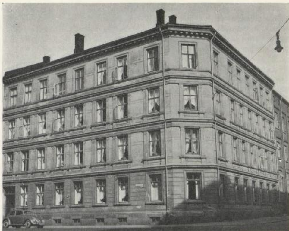
Falsensgt. 24, på hjørnet av Hesselbergs gate, er bygd i annen halvpart av 90-årene.
