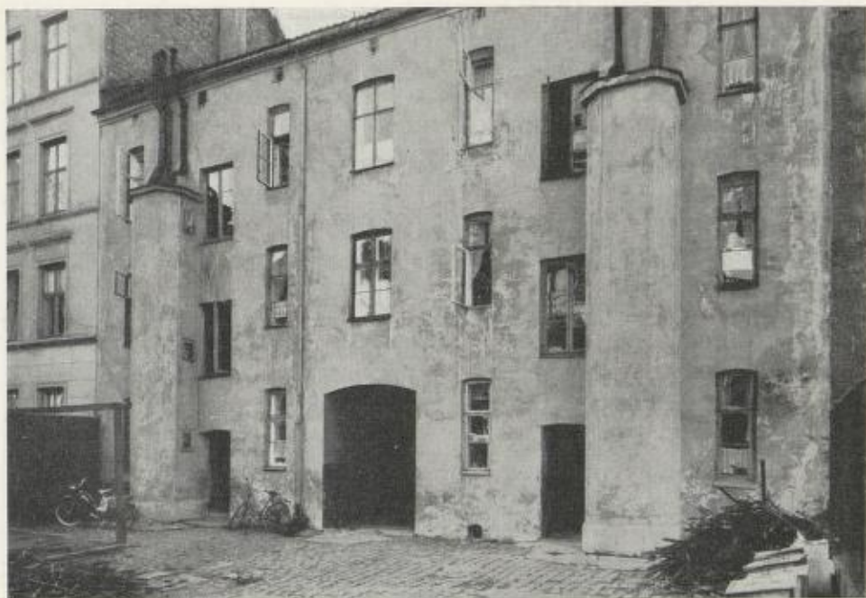
Mellombygningen i Toftesgt. 57. De to små bygningene med bryggerhus og priveter som tidligere sto i dette gårdsrommet, er revet for lenge siden. (Se s. 263 ff.).
