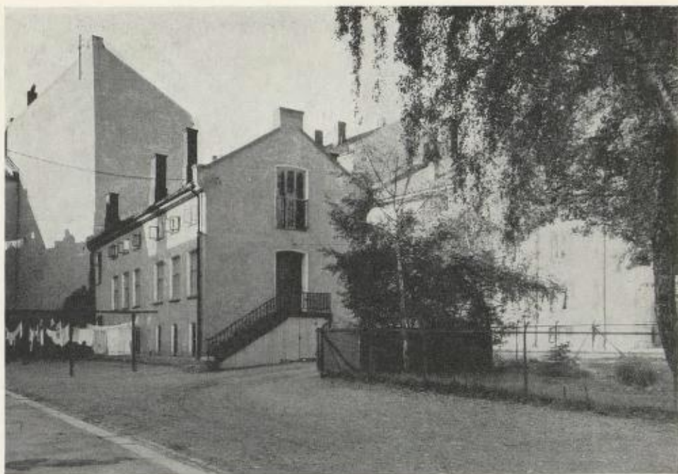
Det virkelige nye ved Sagenes Arbeiderboliger var den rommelige gårdsplassen mellom bygningene. Alt i 1889 var det «Tale om at lade endel af den besaa eller beplante». Et eien-dommelig trekk var også dette uthuset som inneholdt vaskeri med kaldt og varmt vann, fire bad med kar og dusj, rulle- og strykerom, «Ligkjølder» og — i annen etasje — en forsamlingsal for ca. 100 mennesker.
