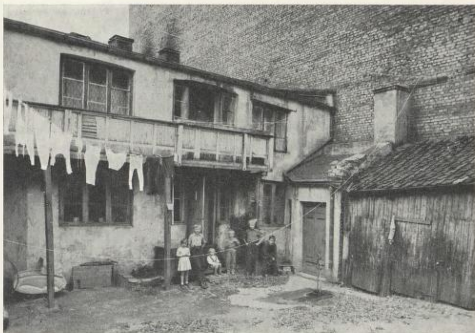
Etterat murtvengen var trådt i kraft, begynte det enkelte steder å gro opp murhus bakom de gamle tømmerhusene i Ny York. Denne bakbygningen i Stolmakergt. 12 var ny ved en branntakst i 1876.
